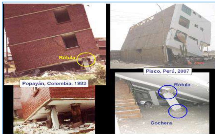
Figura N° 2.11. Formación de rotulas y colapso de edificios con piso blando. (Adaptado de San Bartolomé, s.f.).
