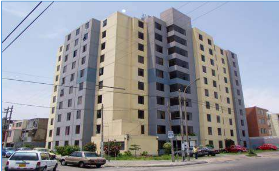
Figura N° 2. 12. Edificio construido con sistemas de muros de ductilidad limitada. (Adaptado de Muñoz, 2004)
