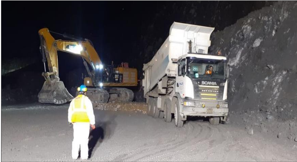
Figura 10 Volquete SCANIA 460 descargando material para lastrado en Cerro Corona
