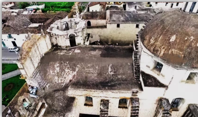
Figura N° 57: Cobertura de la iglesia Belén de Cajamarca . Fuente: Altavista, 2015
