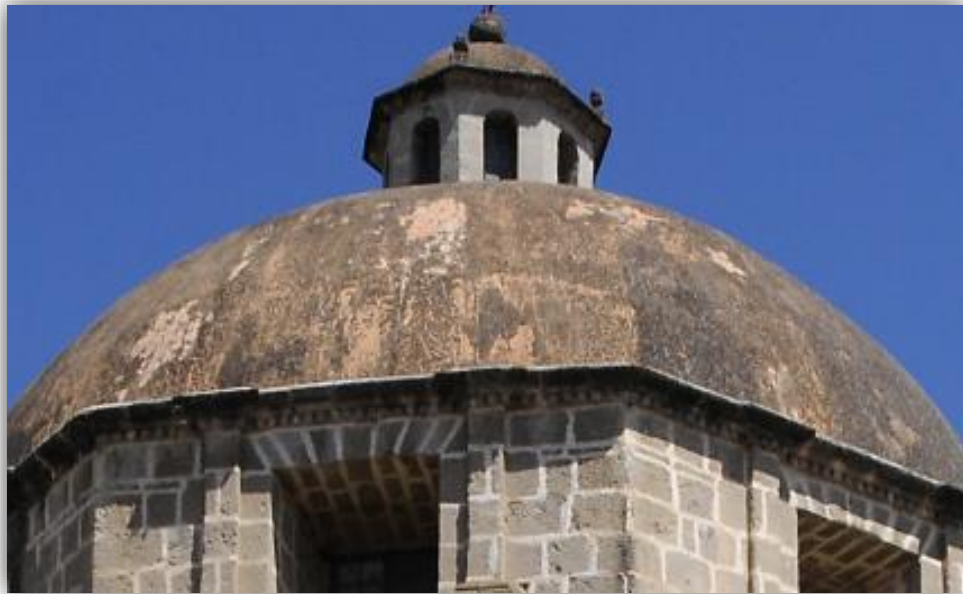
Figura N° 50: linterna sobre cúpula.
