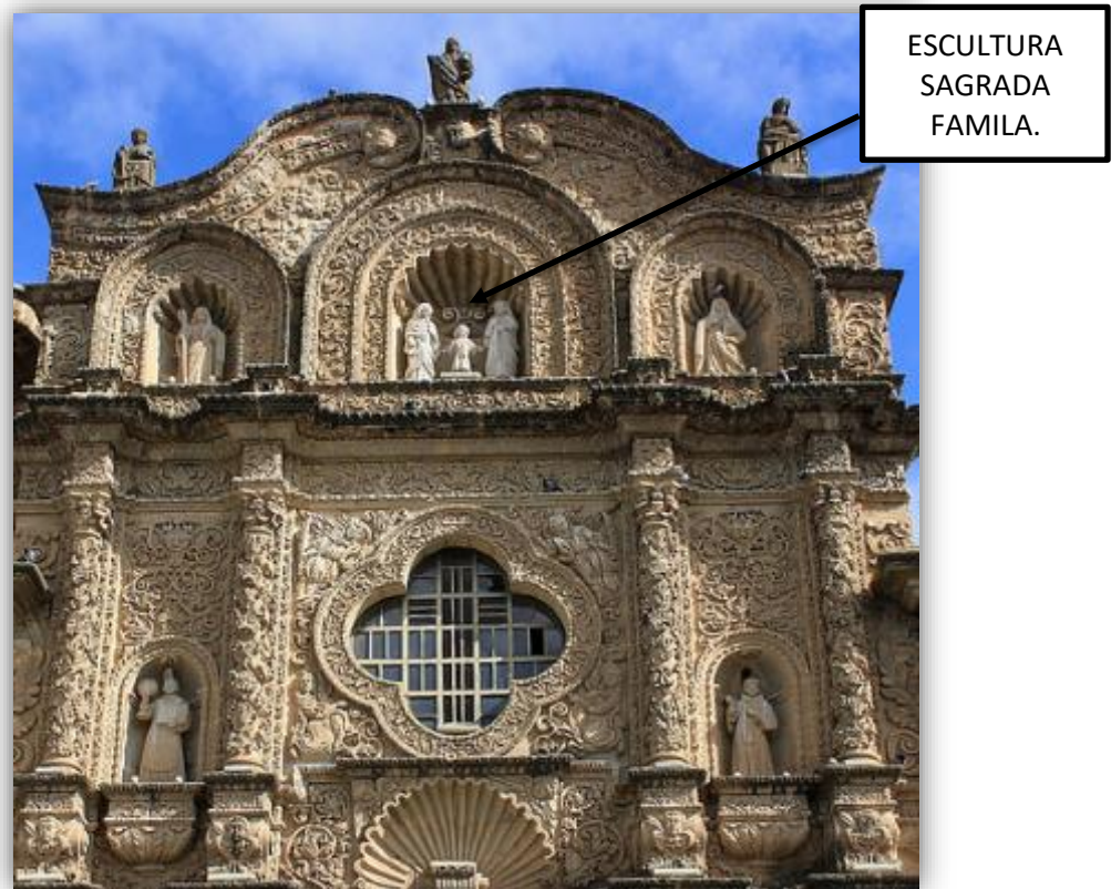
Figura N° 46: Estructura de piedra fachada principal.
