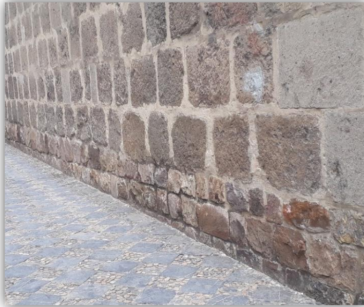
Figura N° 12: Muro de Piedra iglesia Belén.
