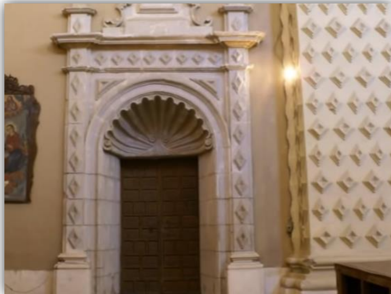
Figura Nº 59: Detalles y acabados interiores en buen estado.
