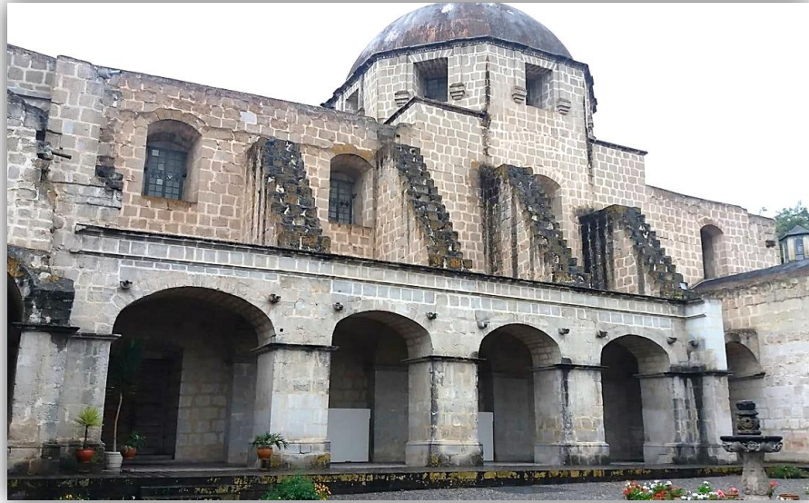
Figura N° 64: Vista lateral de la iglesia Belén
