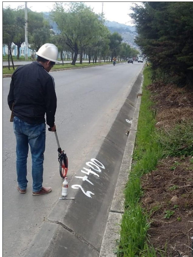
Fotografía N° 14. Medida y señalización utilizando pintura y Odómetro, UM-06.
