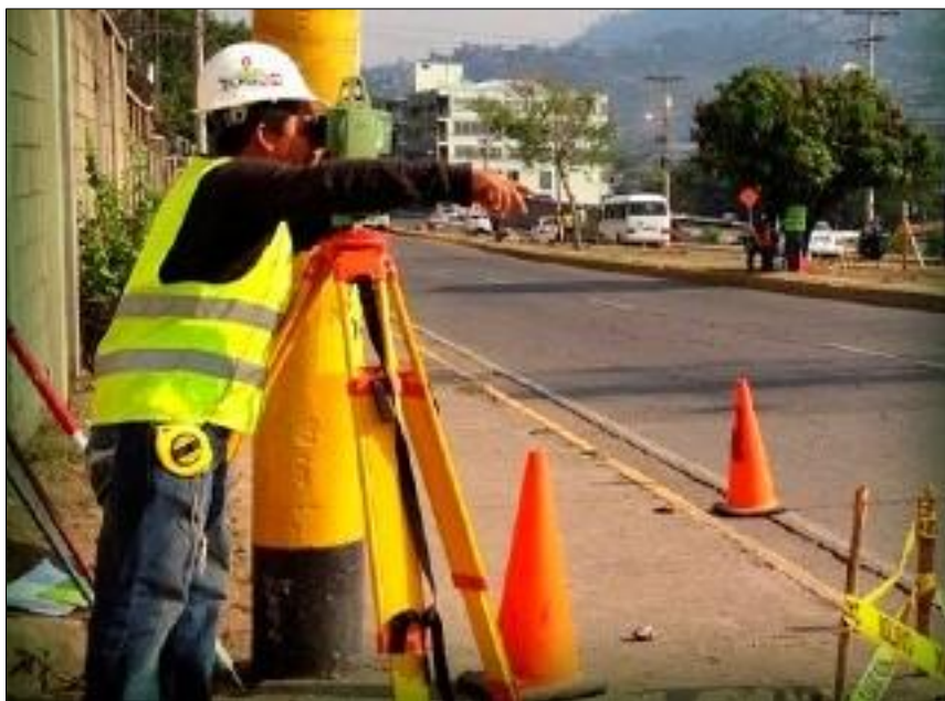
Fotografía N° 07. Levantamiento topográfico de la sección de la vía Cajamarca – Baños del Inca, y algunos otros detalles.
