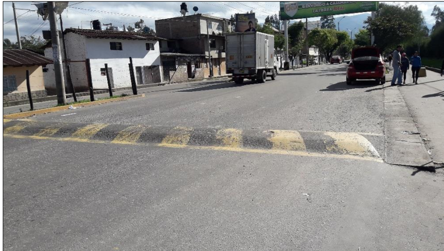
Fotografía N° 04. Detalle de Giba muy pronunciada.
