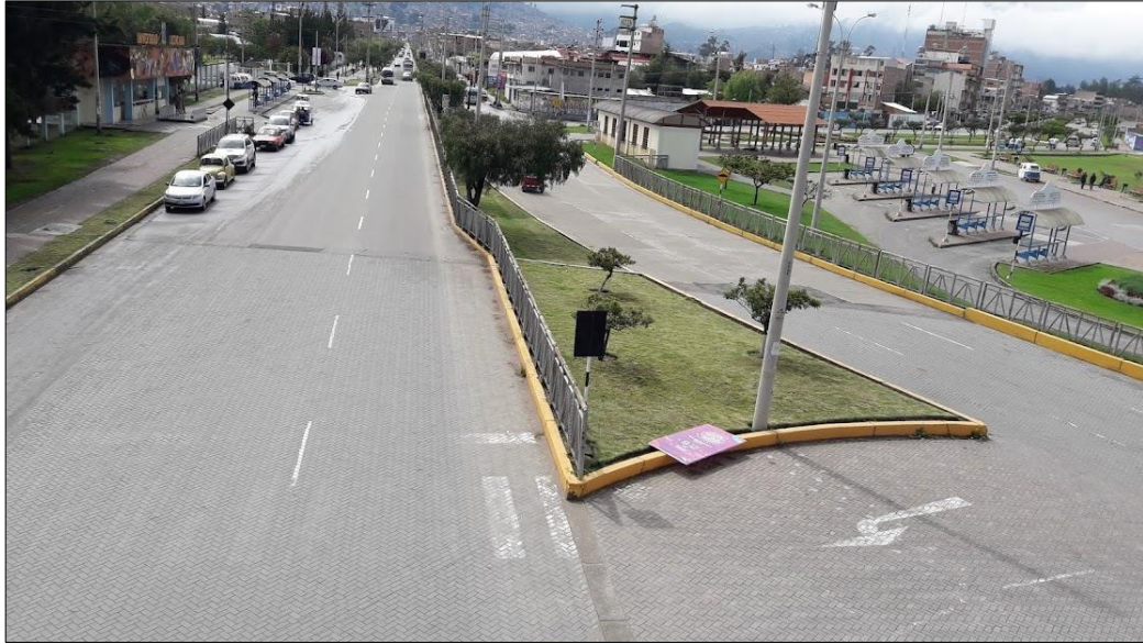
Fotografía N° 06. Presencia de bloquetas en ambas calzadas de la vía.
