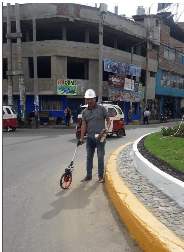
Fotografía N° 10. Inicio de medición con odómetro cada 400 m. (UM-01, Km 00+000)
