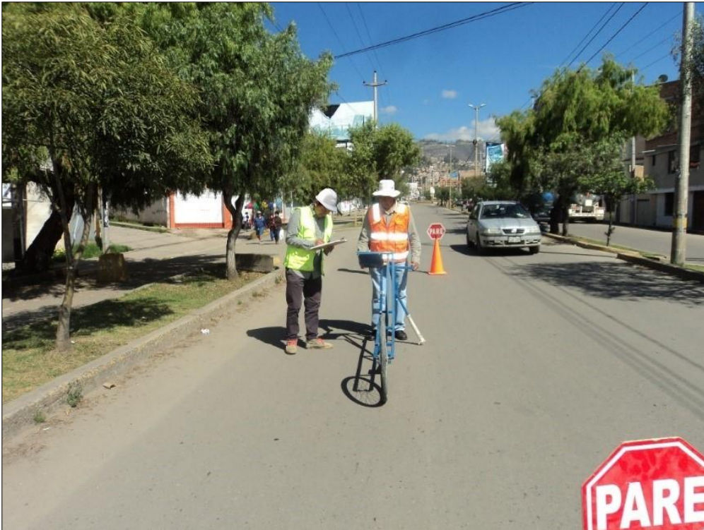
Fotografía N° 19. Lectura y toma de datos, km 00+200m.
