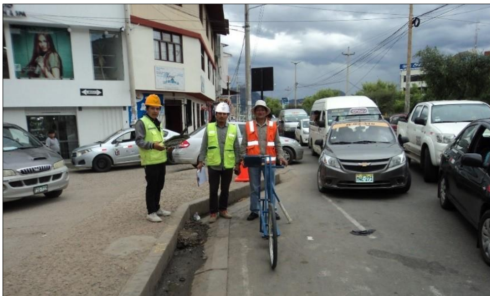
Fotografía N° 26. Fin de medición y toma de lecturas – Calzada 2 (vuelta). (Rotonda Musical – Cajamarca)
