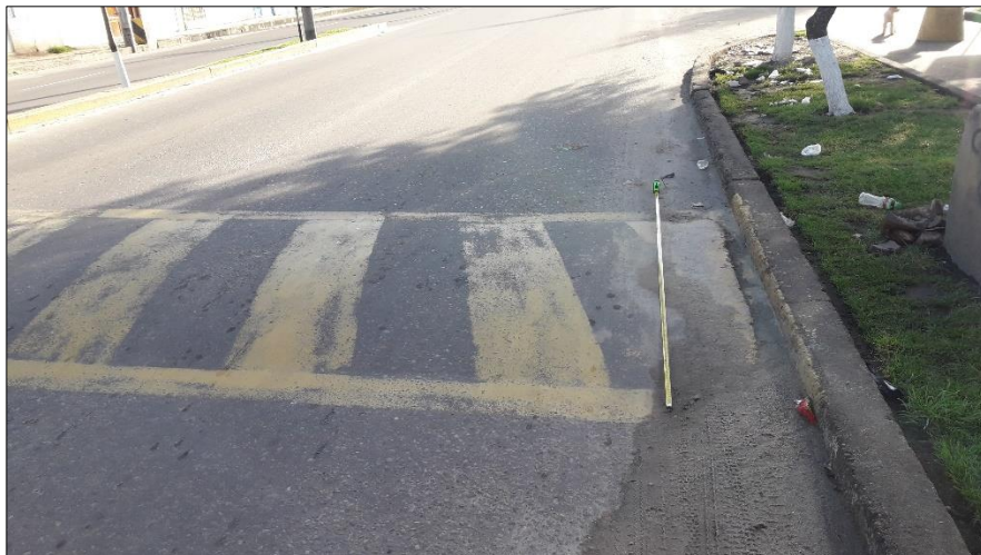
Fotografía N° 01. Detalle de Giba de dos metros de ancho
