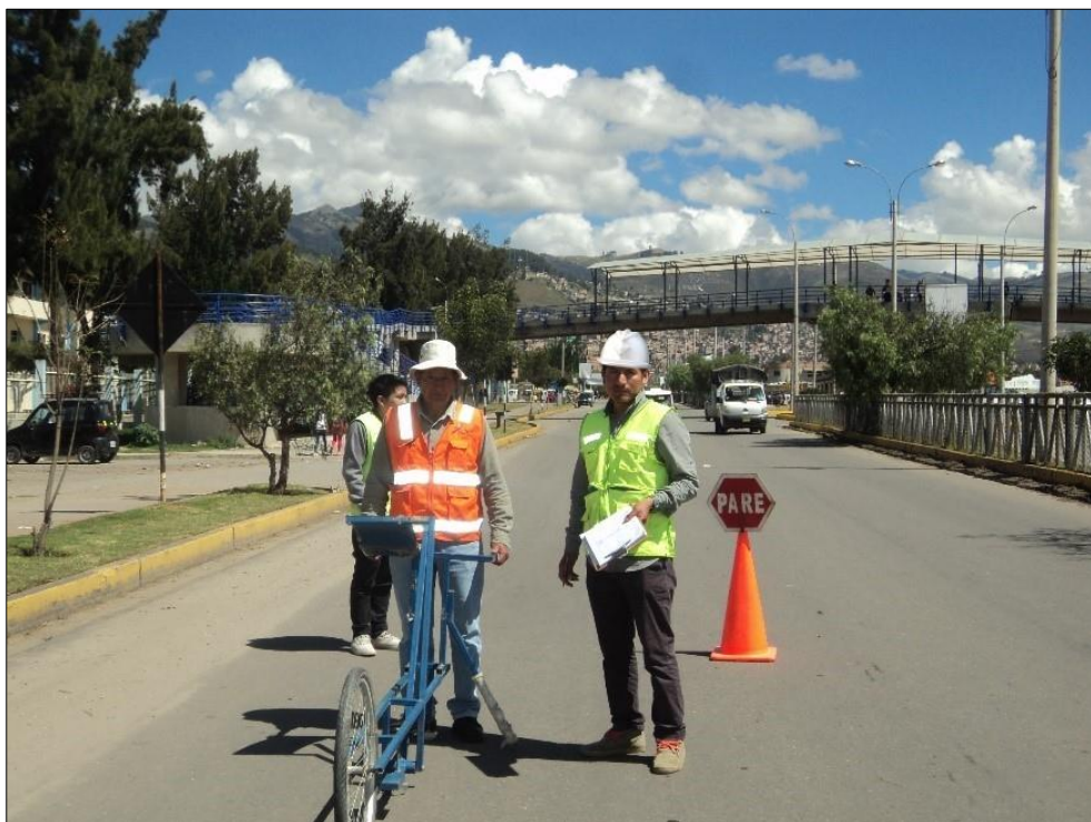
Fotografía N° 22. Lectura y toma de datos con Merlin, Calzada 1 (ida), km 00+880 – Altura Puente Qhapac Ñan
