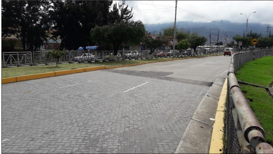
Fotografía N° 02. Inicio de tramo embloquetado, frente a la Universidad Nacional de Cajamarca.
