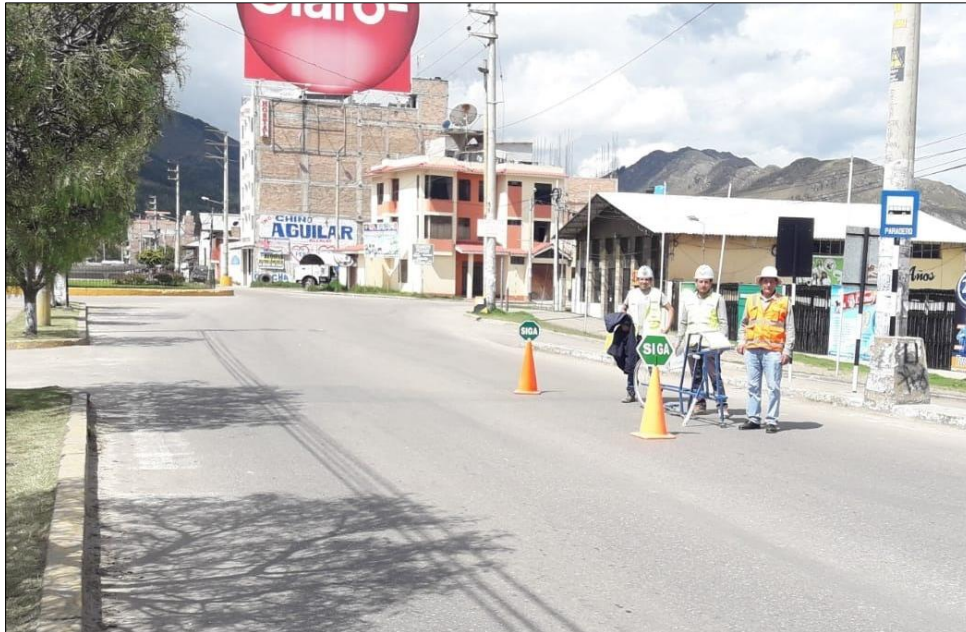
Fotografía N° 25. Fin de toma de datos en la Calzada 1 (ida), km 03+700 (Rotonda Baños del Inca)
