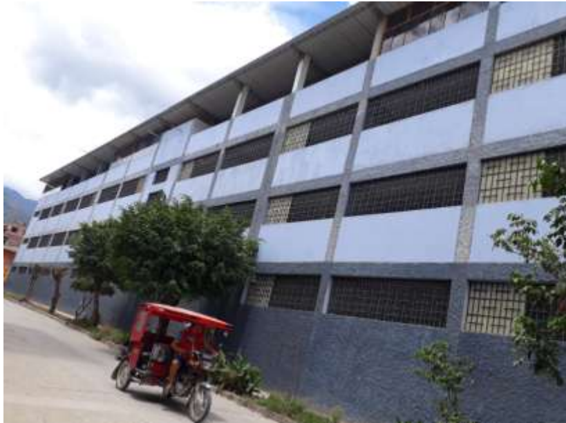
Figura N°33. Vista exterior del centro educativo, no se aprecian grietas ni afectaciones considerables.
