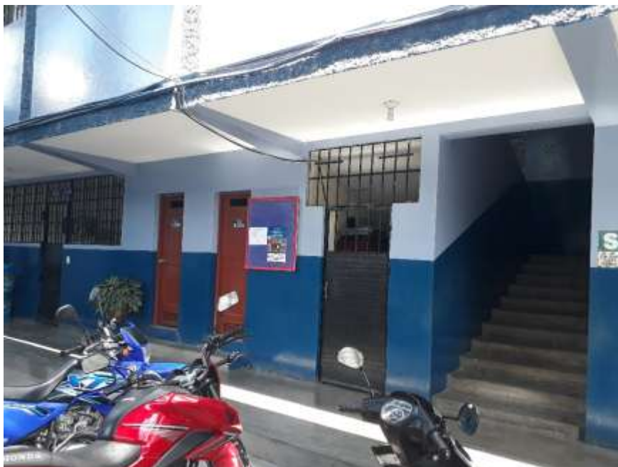
Figura N°34. Estado de algunos elementos estructurales, no presentan grietas ni deterioro, Módulo B nivel 1
