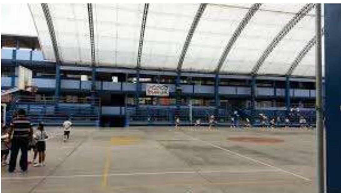
Foto n°2: Vista interior del Colegio Parroquial N°16081 Señor de Huamantanga, Jaén - Cajamarca
