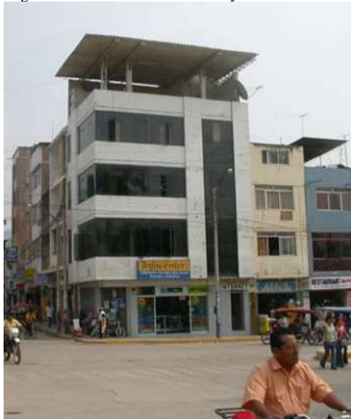
Figura N°3. Viviendas de ladrillo y concreto armado
