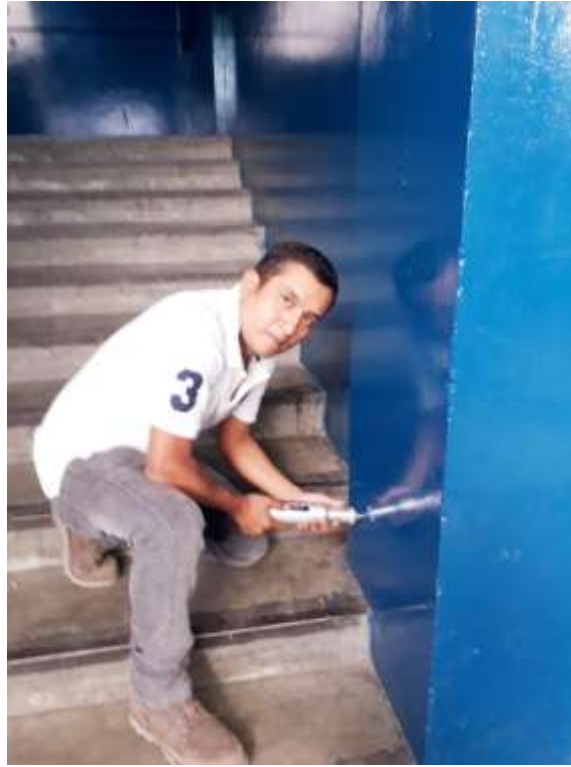
Foto n°5: Procedimiento de realización de ensayos de esclerometría en elementos estructurales
