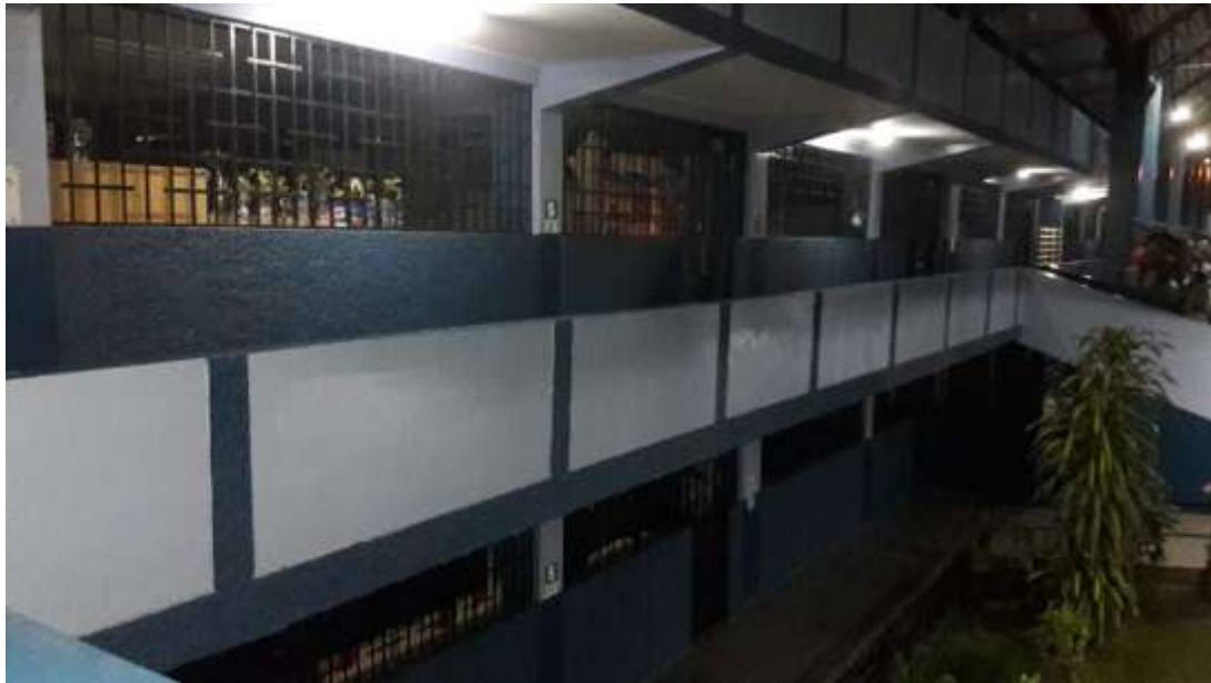
Foto n°4: Vista interior del Colegio Parroquial N°16081 Señor de Huamantanga, Jaén - Cajamarca
