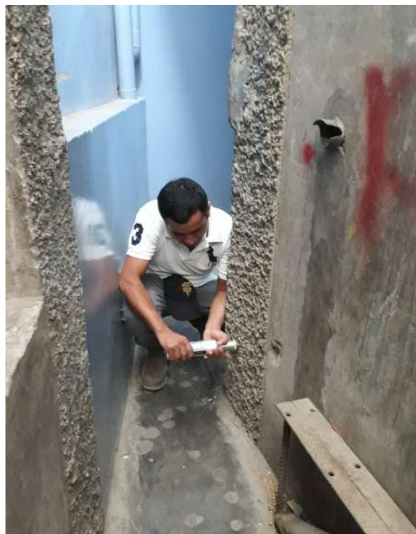
Foto n°6: Procedimiento de realización de ensayos de esclerometría en elementos estructurales
