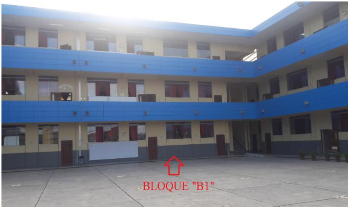
Figura 41: Vista frontal del bloque "B1".
