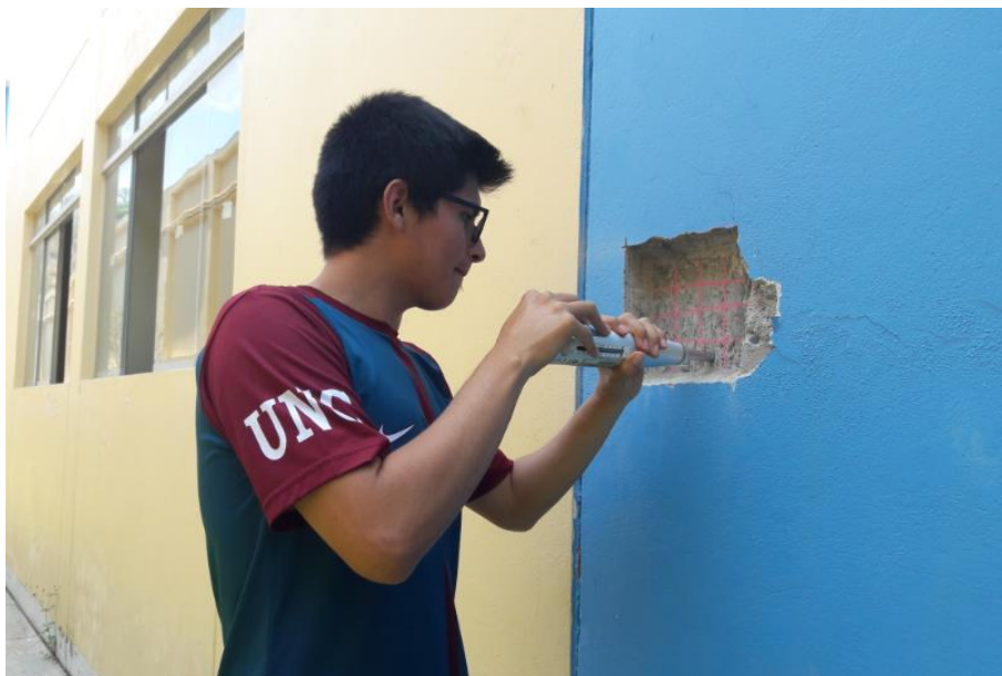
Fotografía 2: Ensayo de Esclerometría en columna C-11 1er nivel – Eje Z' - 25.
