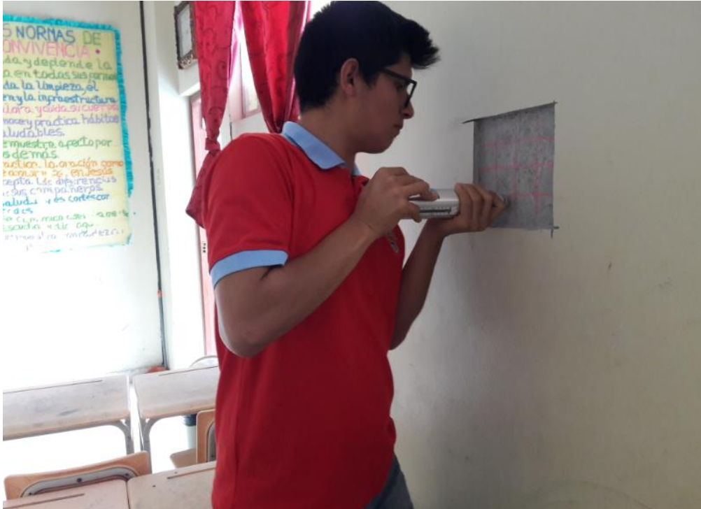
Fotografía 1: Ensayo de Esclerometría en columna 1er nivel – Eje X' - 19.
