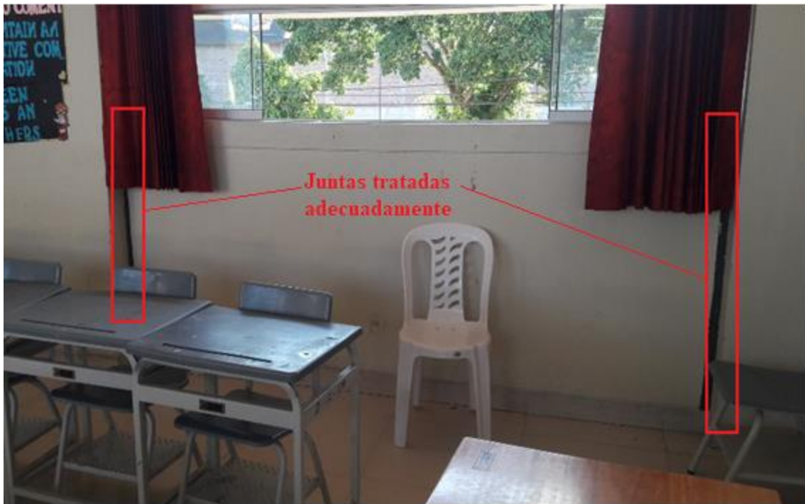
Figura 45: Vista interior de muros aislados del eje Z'.
