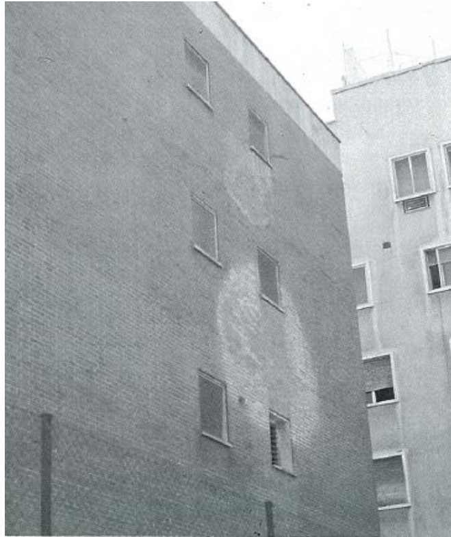
Figura 13: Manchas por humedad accidental.
