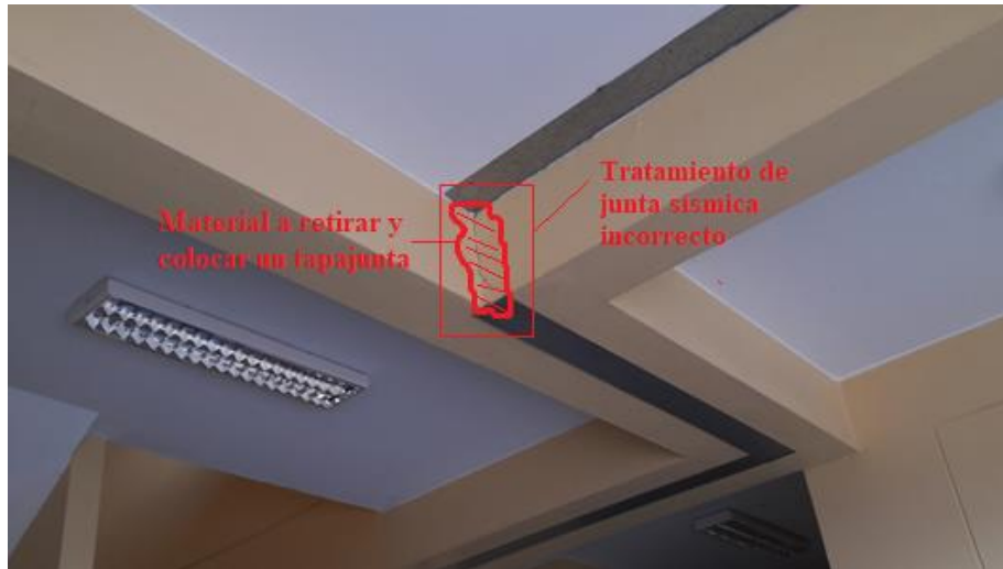
Figura 66: Tratamiento de junta sísmica entre bloques.
