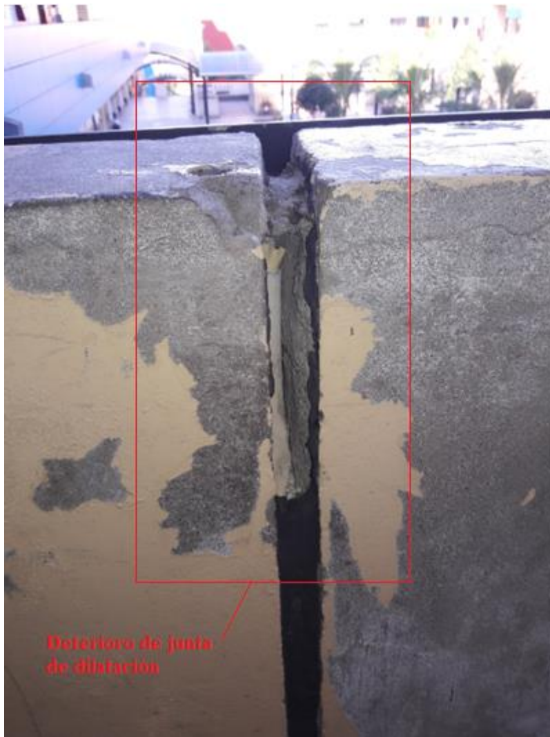
Fotografía 7: Deterioro de junta de dilatación – 2do nivel.
