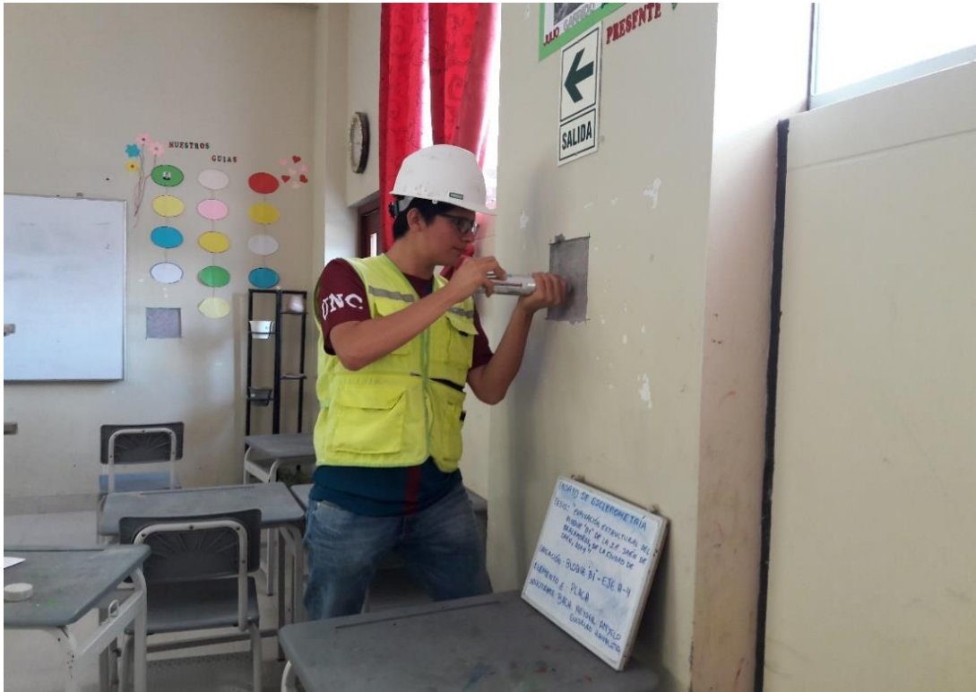
Fotografía 3: Ensayo de Esclerometría en columna 2do nivel – Eje X' – 22.
