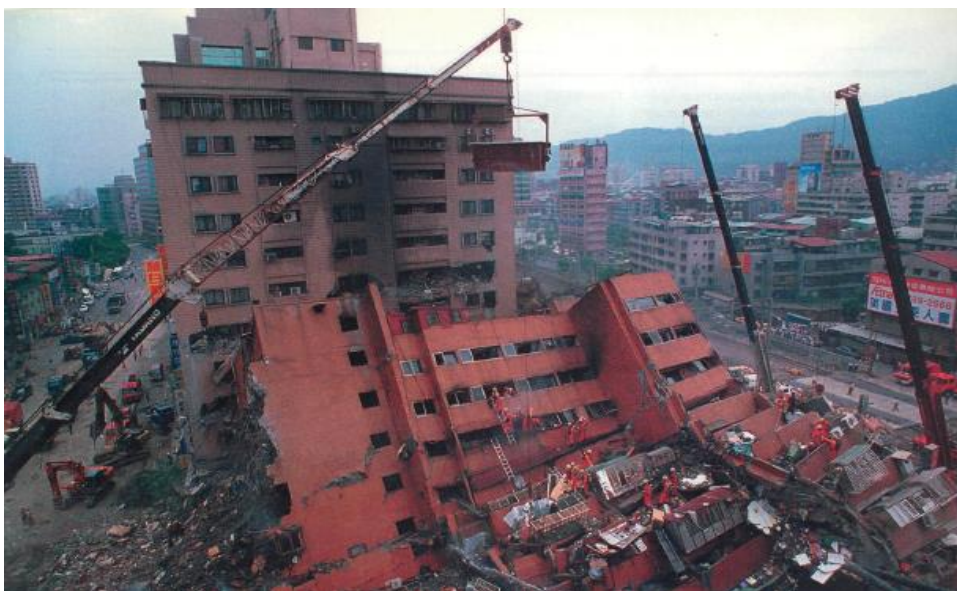
Figura 2: Colapso de Edificación por Sismo.
