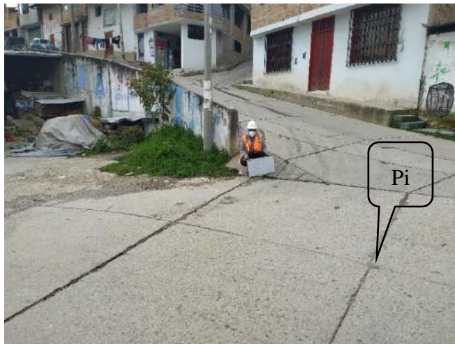
Foto. 2 UM-01 Losa 02. Punto Inicial.
