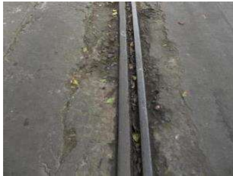
Figura N° 45 Cruce de Vía Férrea - Baja Severidad.
