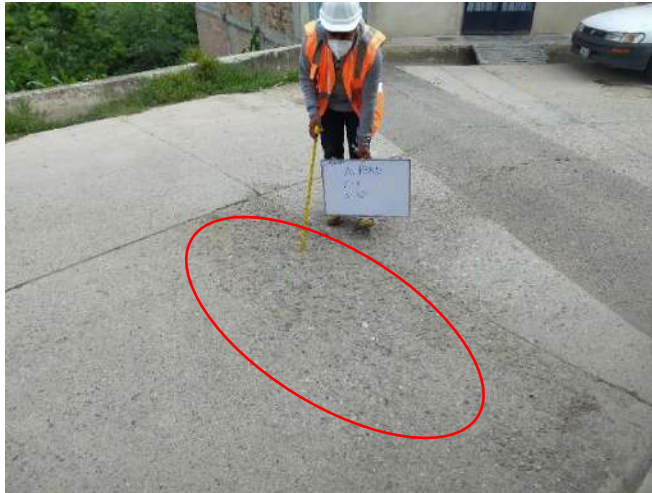
Foto. 4 UM-03 Losa 36. Pulimiento de Agregados.
