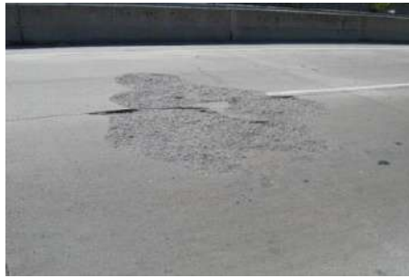
Fuente: Reparación de pavimento de hormigón
