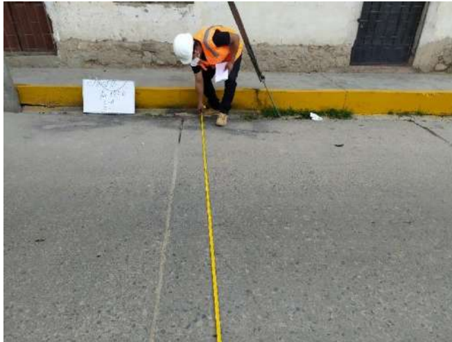
Foto. 19 Toma de Datos de la Sección de la Vía.
