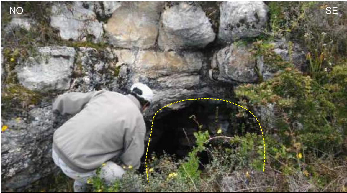
Foto 19. Formación de Caverna siguiendo el buzamiento de la estratificación de la Fm. Cajamarca. Con 1.20 m de alto y 1.5 m de ancho. Ubicada en Machaypungo Alto. Longitud: 765345 / Latitud: 9263080. Con vista al Noreste.
