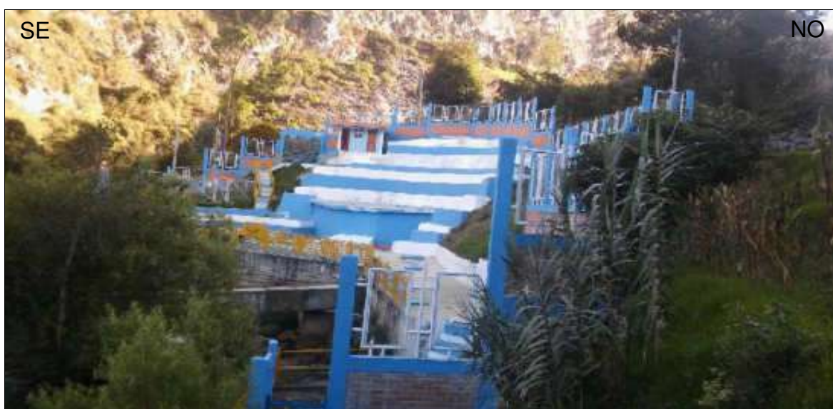
Foto 23. Exurgencia denominada los 3 chorros de agua proveniente de aparato kárstico de Machaypungo, con caudal permanente y pequeñas variaciones durante el año, captada por SEDABAM para abastecer de agua potable a la ciudad de Bambamarca.
