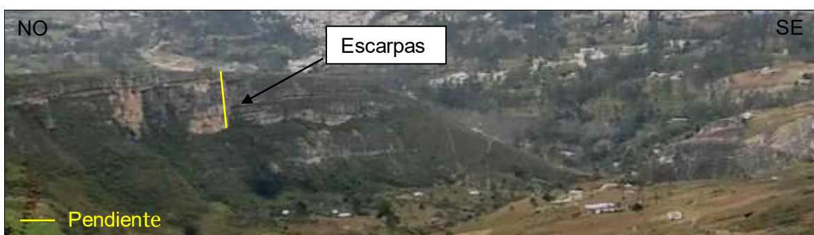
Foto 6. Escarpa con pendiente de 85 °. Sobre la Fm. Cajamarca, en dichas escarpas se presenta caída de rocas, ubicada a la margen izquierda de la quebrada Machaypungo. Longitud: 770973 / Latitud: 9262813. Con vista al Noreste.
