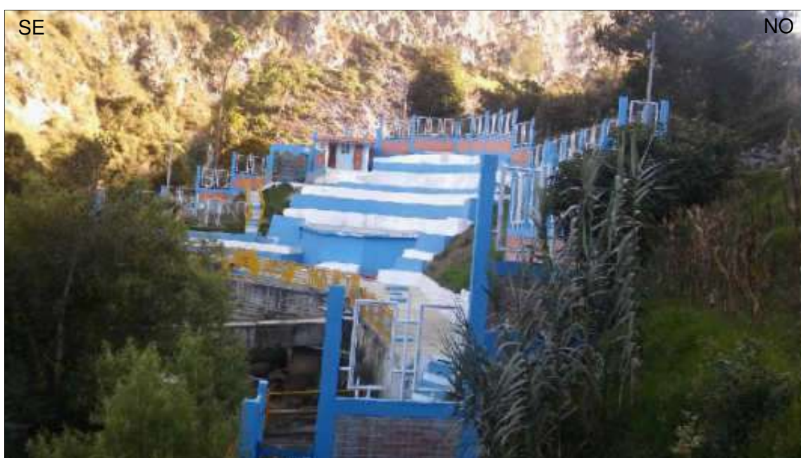
Foto 93. Exurgencia 1: Exurgencia denominada los 3 chorros de agua proveniente de aparato kárstico de Machaypungo, con caudal permanente y pequeñas variaciones durante el año, captada por SEDABAM para abastecer de agua potable a la ciudad de Bambamarca. Ubicada a la margen izquierda del río Maygasbamba en las coordenadas. Longitud: 771850 / Latitud: 9262732.
