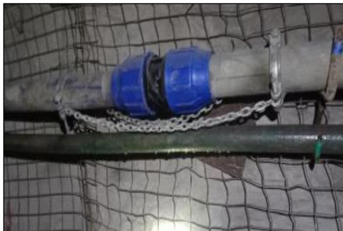
Figura 6. Abrazadera y cadena de sujeción en tubería de aire.
