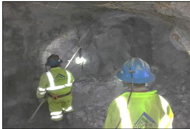
Figura 11. Desatado de rocas en frente de sección 8'x8'
