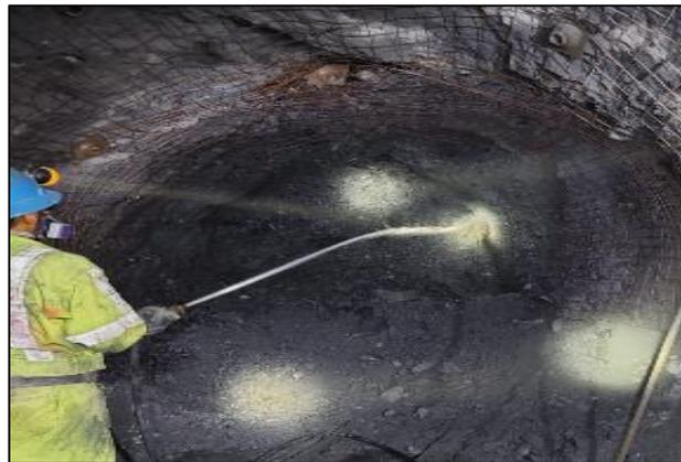
Figura 10. Regado de carga en frente de sección 8'x8'
