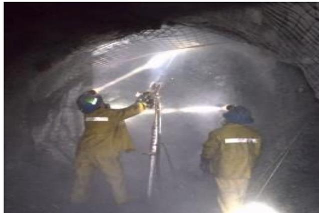
Figura 7. Perforación en frentes de sección 8'x8' con perforadora jackleg
