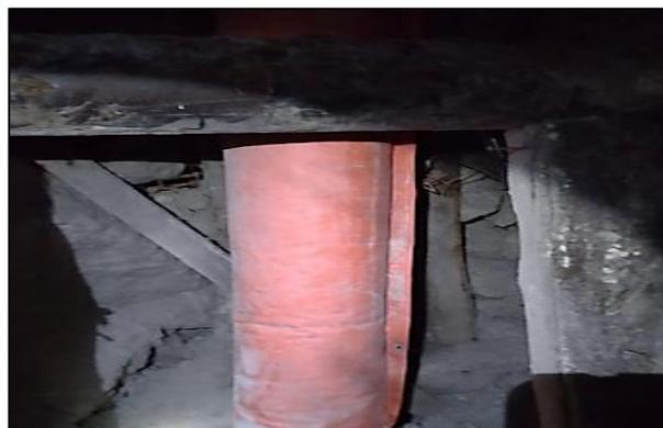
Figura 18. Instalación de manga de ventilación en Chimenea
