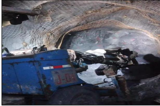
Figura 8. Perforación de frente 8' x 9' con jumbo electrohidráulico
