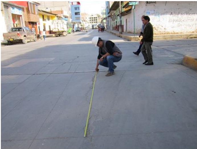
Fotografía 05. Losa dividida de severidad media.
