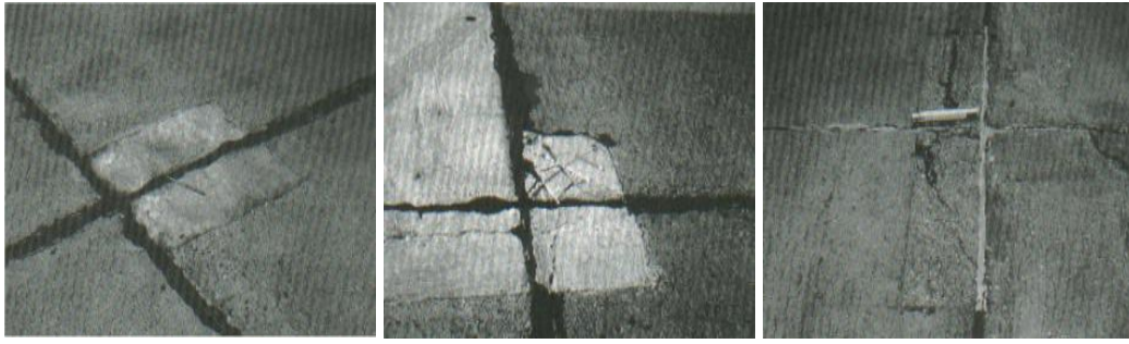
Figura 16 Parche pequeño (Izquierda severidad baja, centro severidad media e izquierda alta severidad)
