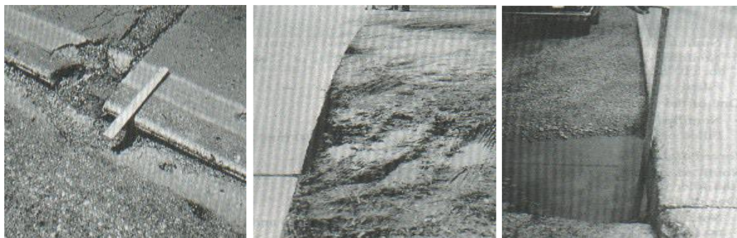
Figura 13 Desnivel carril / berma (Izquierda severidad baja, centro severidad media e izquierda alta severidad)
