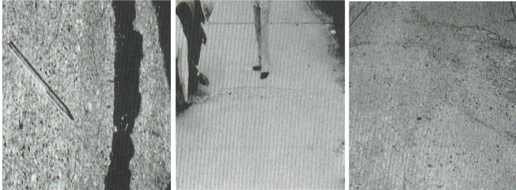
Figura 10 Grieta de durabilidad (Izquierda severidad baja, centro severidad media e izquierda alta severidad)
