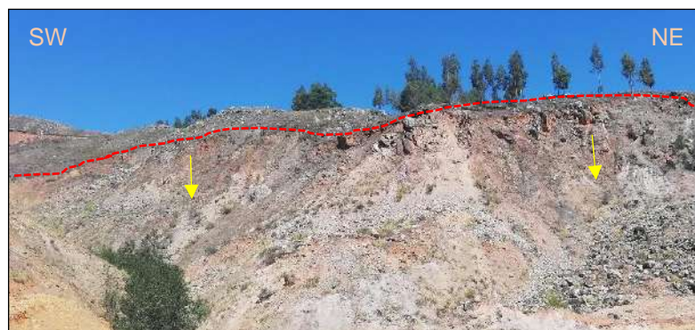
Foto 3.17. Deslizamiento ubicado en el margen izquierdo de la quebrada Andaden, Parte media de la Microcuenca. Coordenadas: N: 9198260 E:783296 Cota:2978
