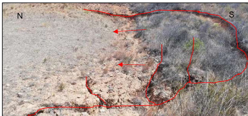
Foto 3.26. Zona con proceso de reptación - presencia de grietas. Coordenadas: N:9197891 E:782465 Cota: 3181
