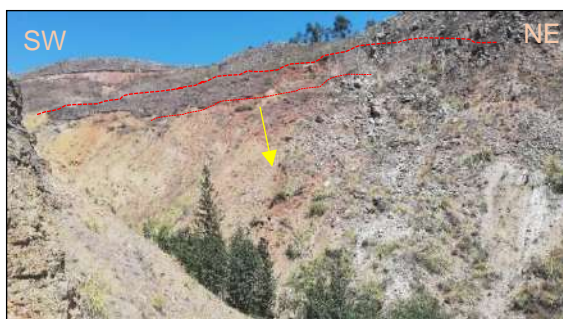
Foto 3.18. Deslizamiento ubicado en la parte media de la Microcuenca. Coordenadas: N: 9198250 E:783184 Cota: 3022
