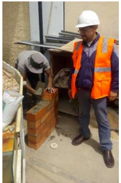
Fotografía 16. Elaboración de muretes con mortero sin cal, con espesor de junta de 1 cm.
