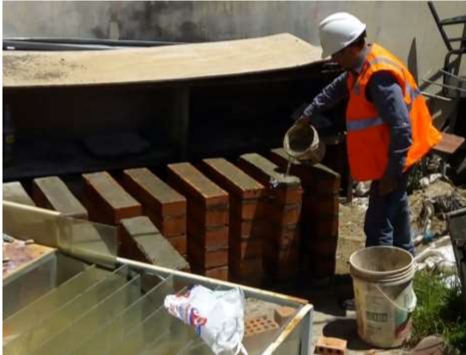
Fotografía 20. Curado de muretes de albañilería.
