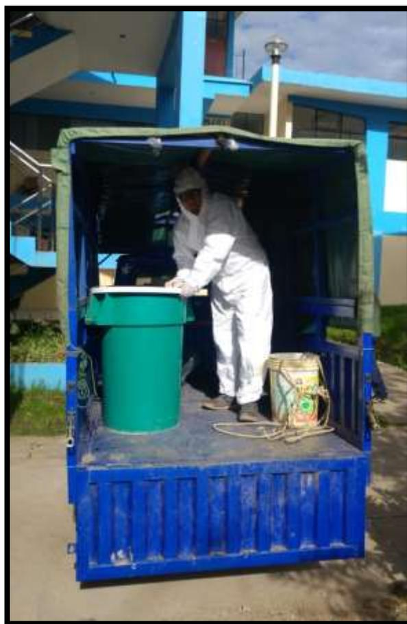
Figura 18: Llenado y activación de reactores biológicos con agua residual
