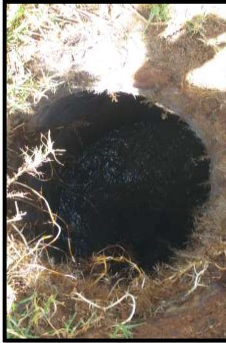
Figura 4: Buzón de alcantarillado para toma de muestras.
