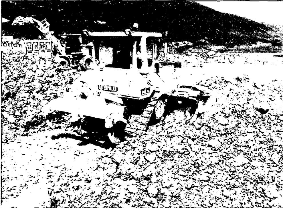
**FIGURA 50. TRASLADO DE MATERIAL DE AFIRMADO EN CANTERA**
