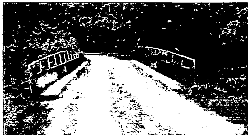
Fotografía 4.1 Puente yerbabuena sobre el rio Chugur km 2+200
