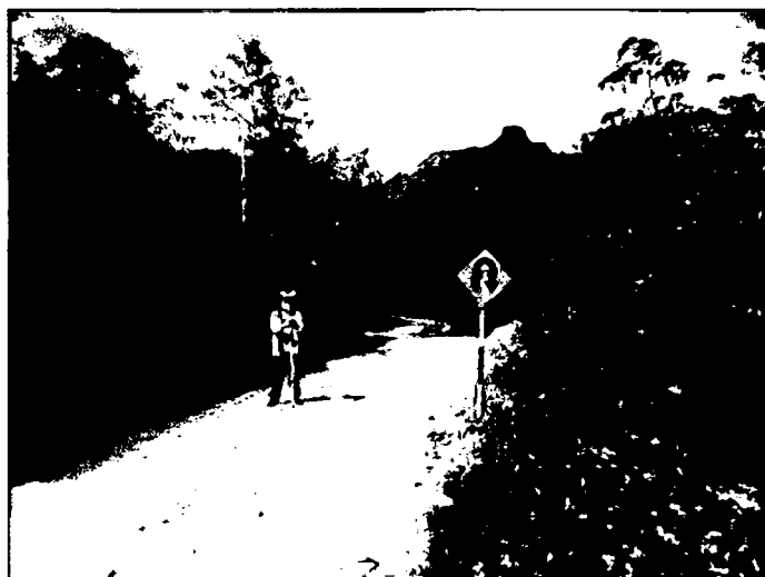
FOTOGRAFIA N°03: Ayudante tomando un punto en el eje de la vía.
