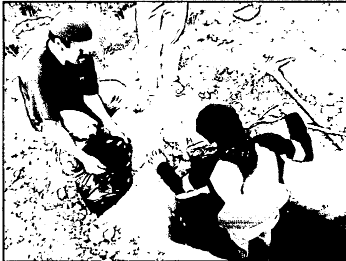
FOTOGRAFIA N°07: Embolsado de la muestra extraída de la calicata por estrato.
