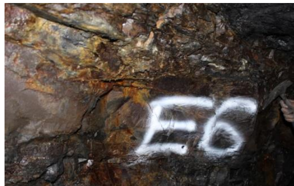
Figura 4.6. Geología. Estación N°6.
