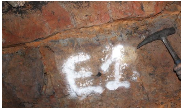
Figura 4.1. Geología. Estación N°1.
