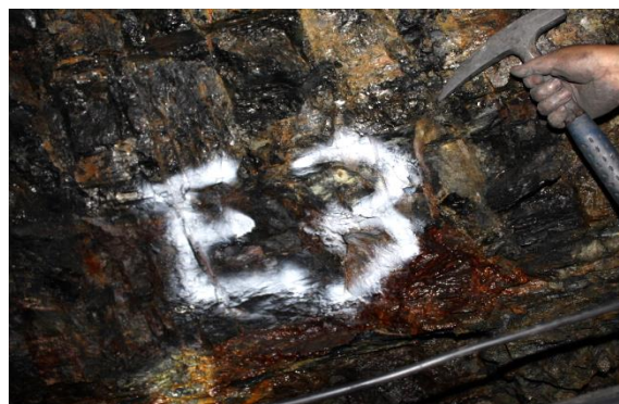
Figura 4.3. Geología. Estación N°3.
