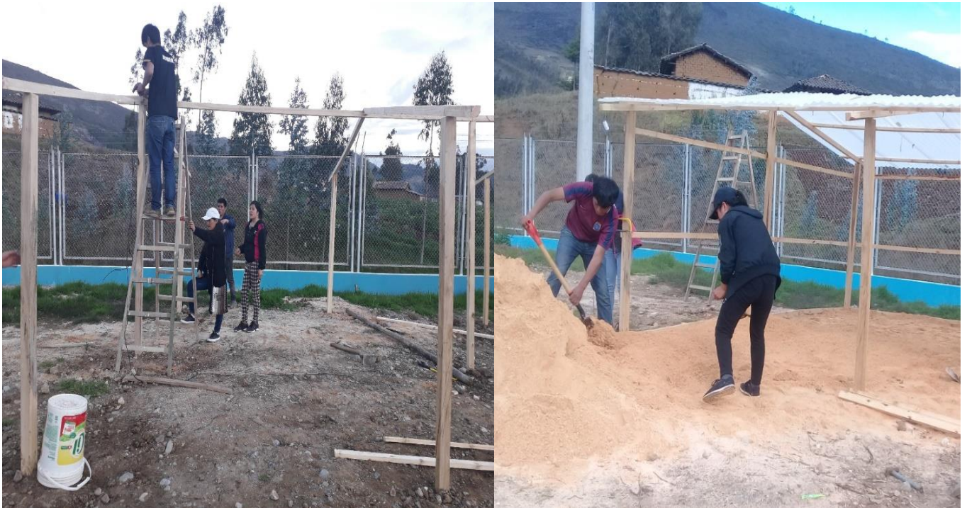
Imagen 1. Construcción de la caseta
