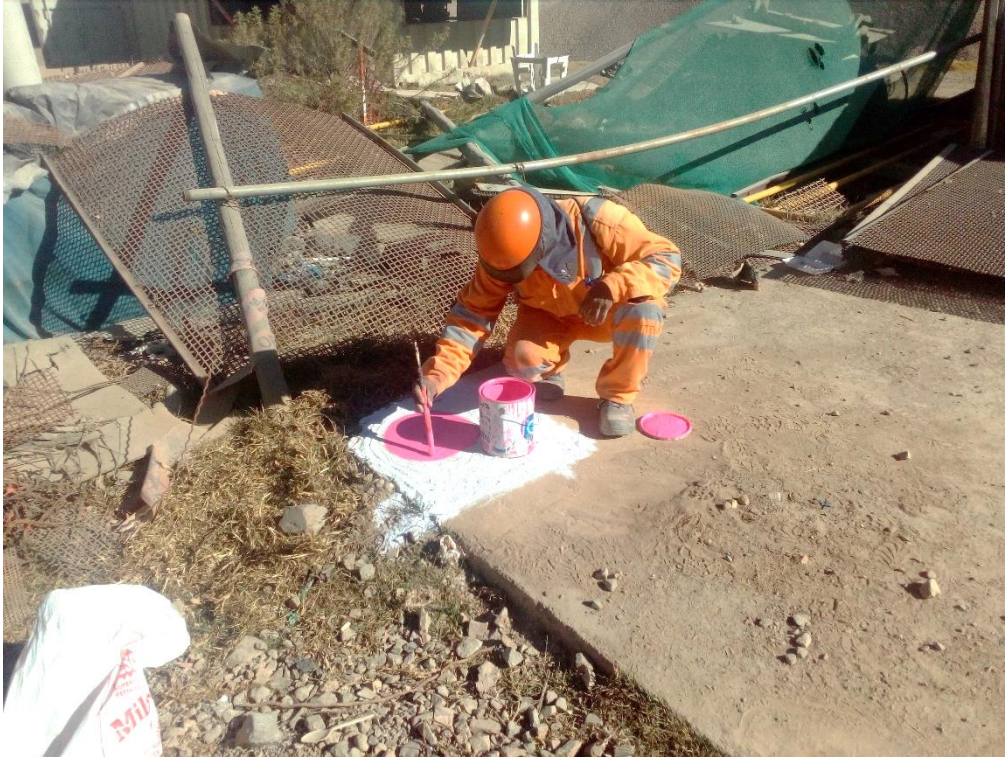
Fotografía 9. Demarcacion y pintado de GCP.
