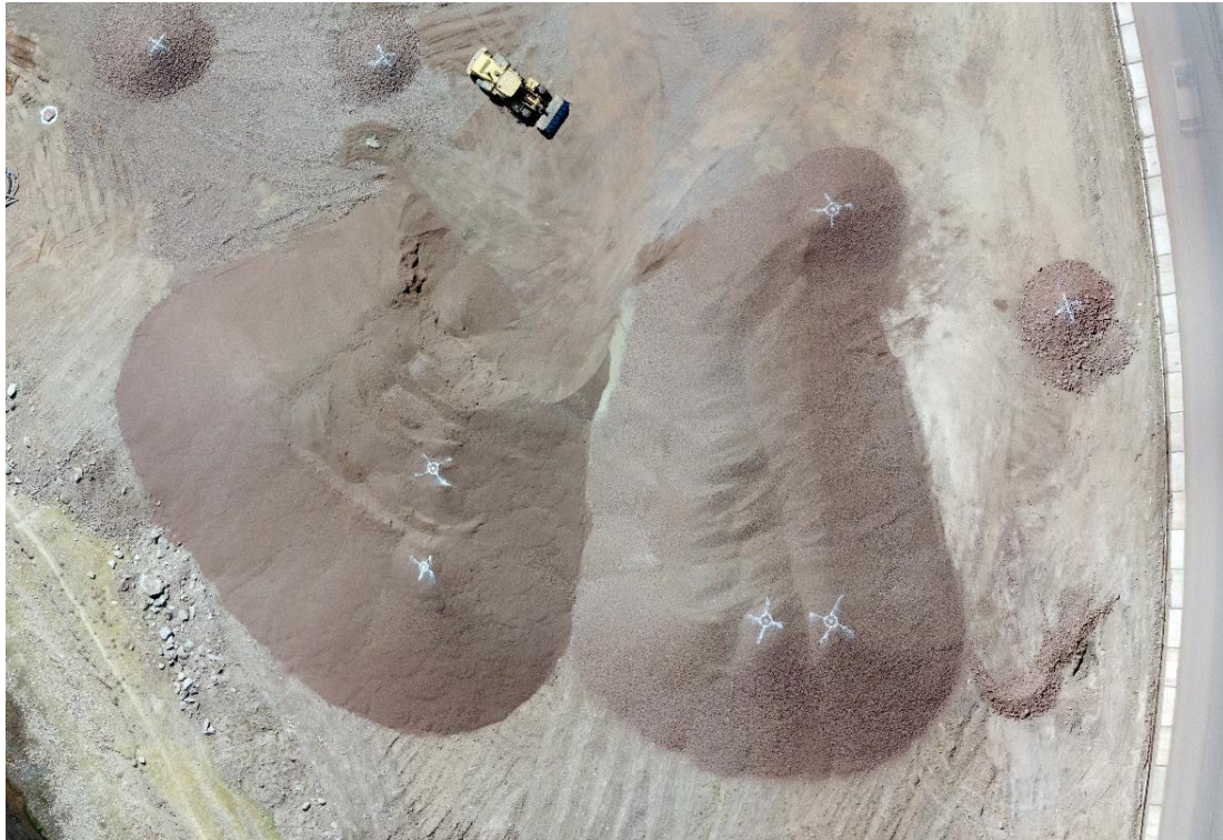
Fotografía 3. Vista del acopio de materiales 03 - km 25+950.
