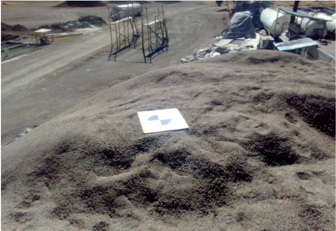
Fotografía 15. Colocacion de puntos de apoyo con dianas de prefabricadas.
