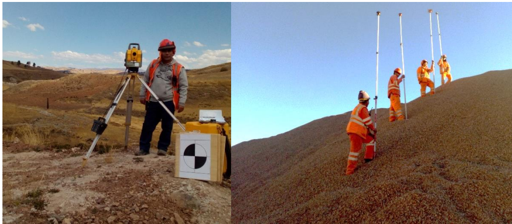
Figura 69. Levantamiento topográfico con estación total
