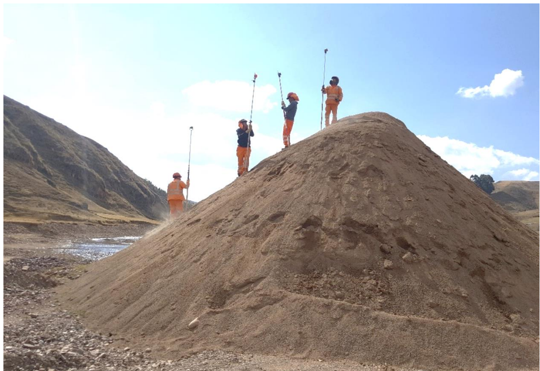
Fotografía 14. Levantamiento topograficos con estacion total.
