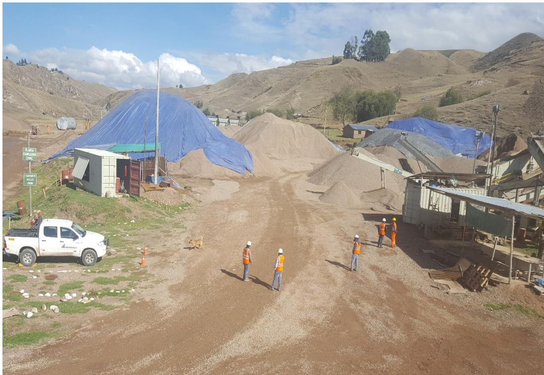
Fotografía 4. Inspeccion de zona de estudio – km 24+300.
