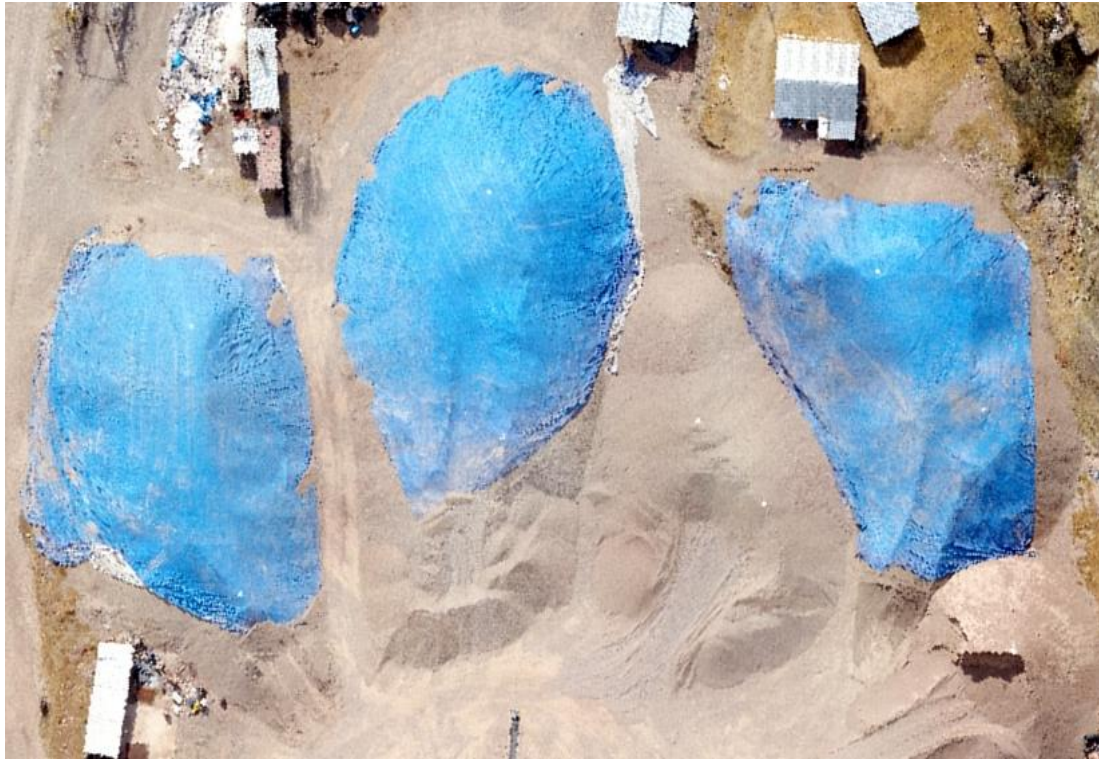
Fotografía 1. Vista del acopio de materiales 01 - km 24+300.
