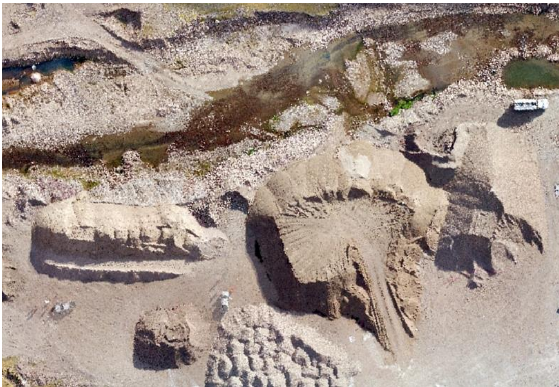
Fotografía 2. Vista del acopio de materiales 02 - km 24+300.
