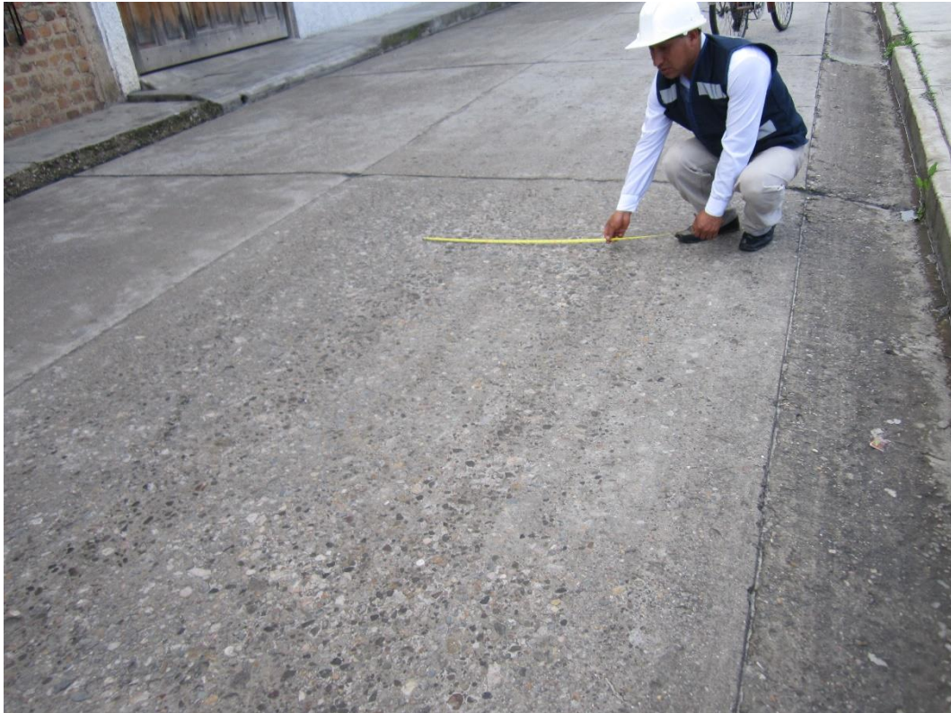
Imagen 2. Pulimiento de agregados.
