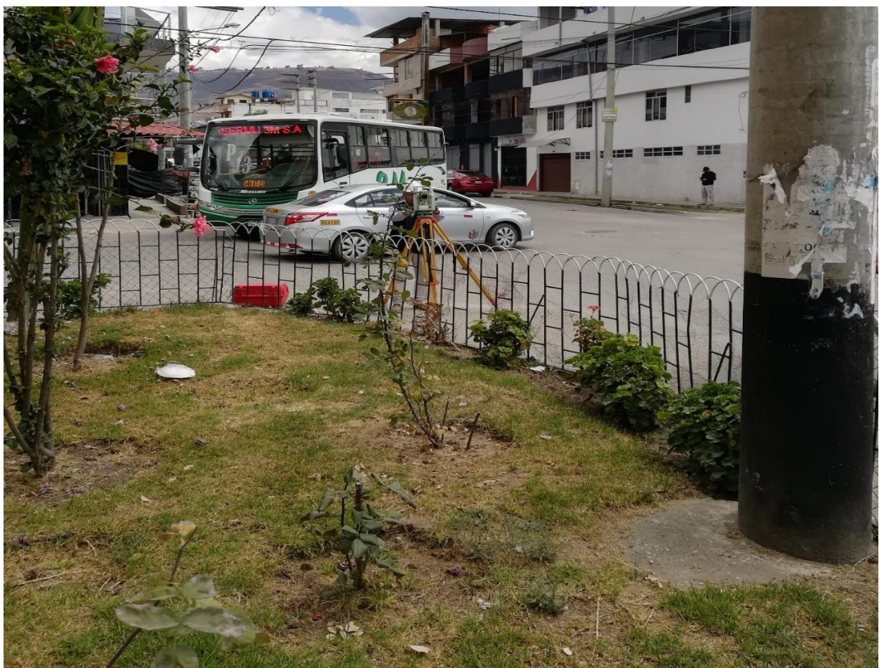
Imagen 13: Levantamiento de Psj. Los Fresnos, calzada con pavimento rígido.
