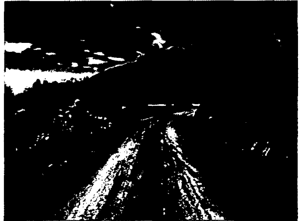
Figura 10 ( antes) y figura 11 ( después).En el km 15+080 aprox, vista de ahuellamiento en la plataforma
