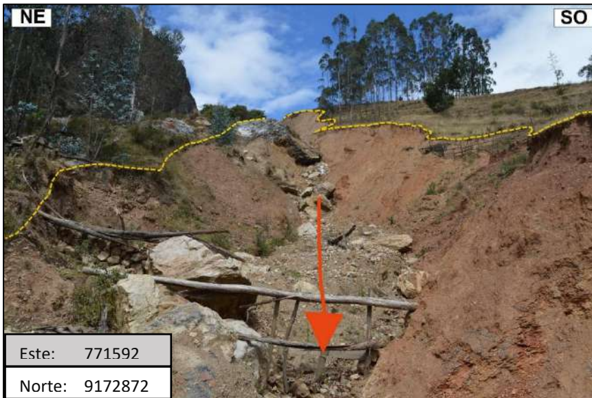
Foto 25: Se observa delimitado de color amarillo la quebrada Alisos, en cuyo cause se observan fragmentos de roca, suelo suelto y material orgánico, los cuales constituyen productos de un flujo de detritos durante la época de invierno del año 2017 (progresiva Km 03+030).
