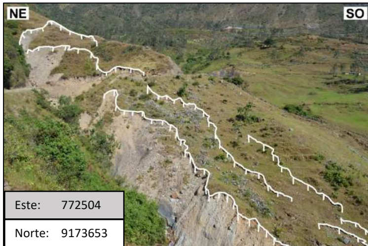
Foto 22: Se observa delimitada con líneas blancas las escarpas múltiples de derrumbes en el flanco derecho de la carretera hacia Rambrán, en el sector Las Lúcumas (progresiva Km 07+000).
