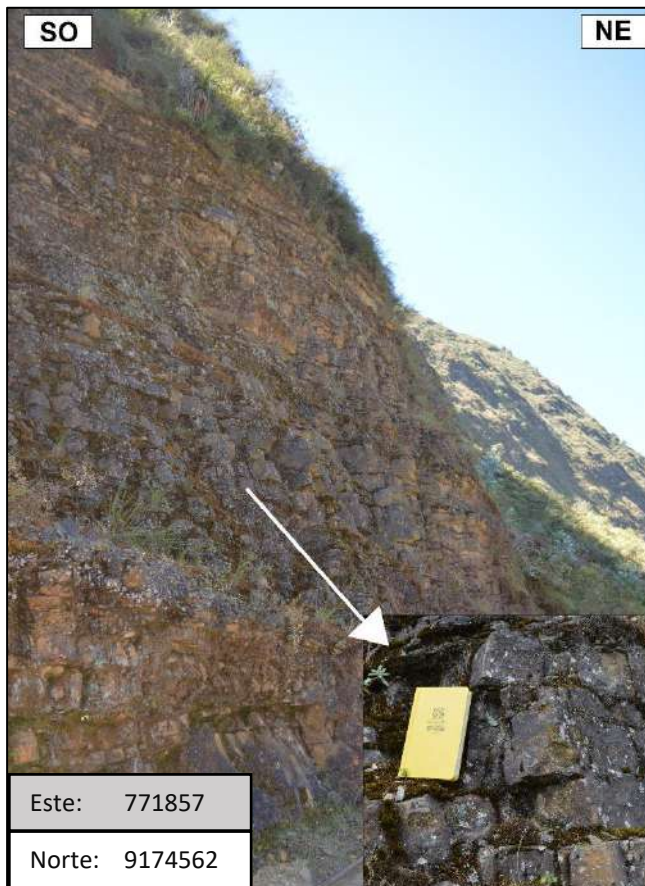
Foto 29: Se observa un afloramiento de areniscas pertenecientes de la Formación Chimú, correspondiente a la estación geomecánica 03, en el sector Unión Casipe (progresiva Km 08+370).
