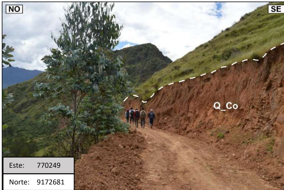
Foto 7: Depósitos Coluviales en un corte de talud, se encuentran suprayaciendo rocas de la Formación Farrat (progresiva Km 01+300).
