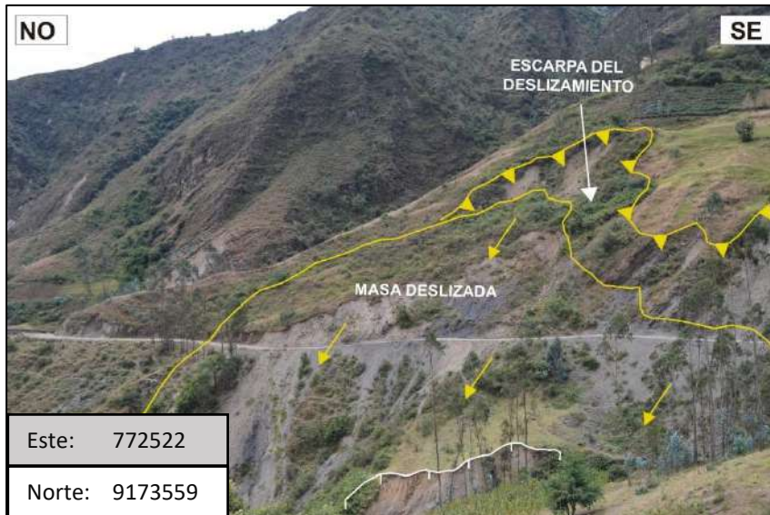
Foto 17: Deslizamiento rotacional ubicado en la margen derecha de la Quebrada las Palmas (progresiva Km 06+800).
