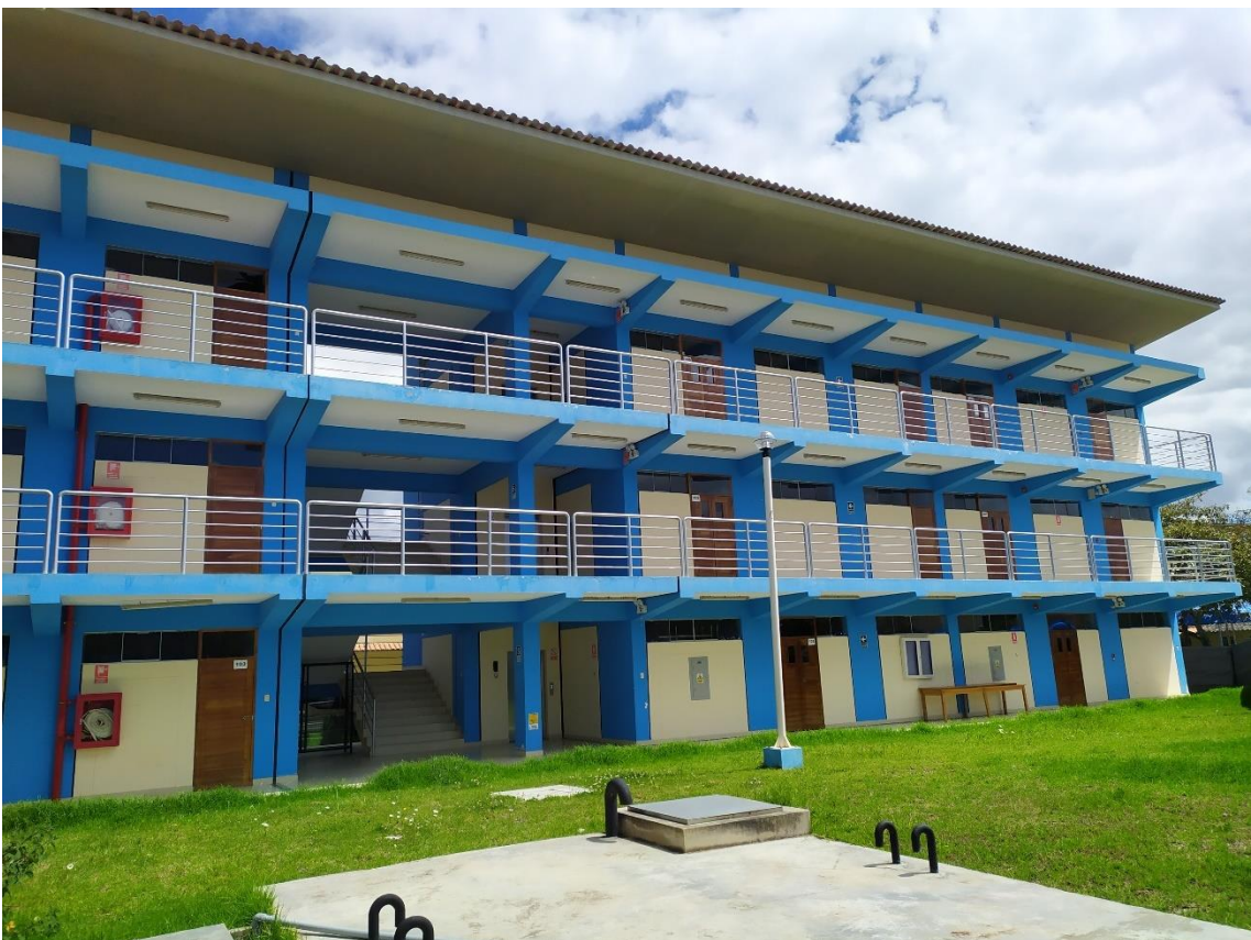
Fotografía 24: Vista al frontis del módulo A (Fuente: Captura propia)
