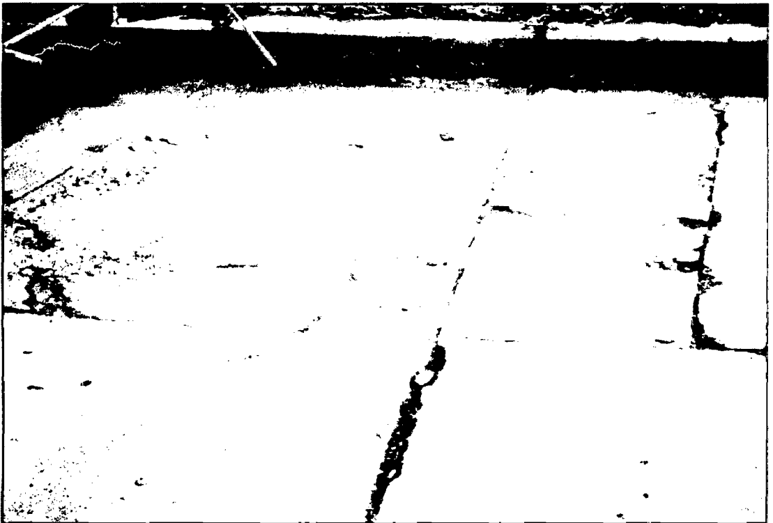
Figura 25. Grieta longitudinal de severidad media (M)
