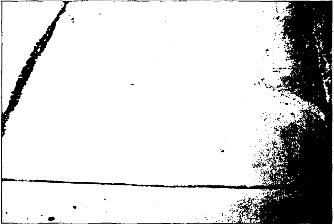
Figura 24. Grieta diagonal de severidad media (M)
