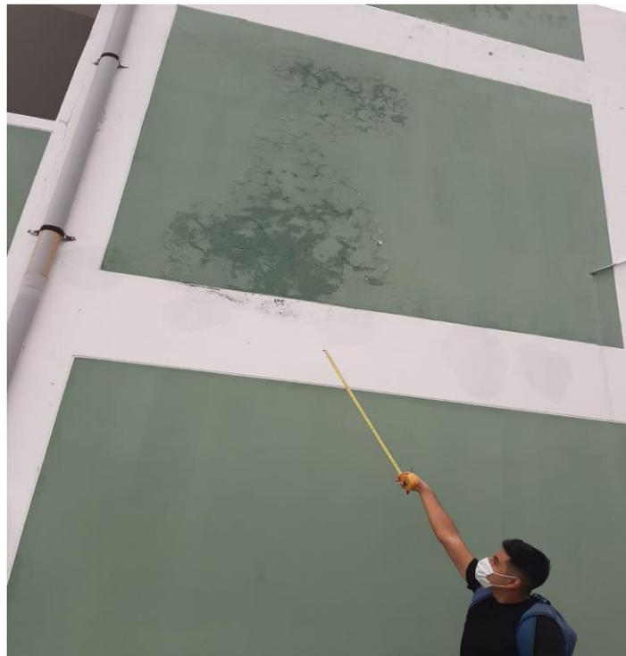
Fotografía 5. Verificación de juntas sísmicas de los bloques de la edificación
