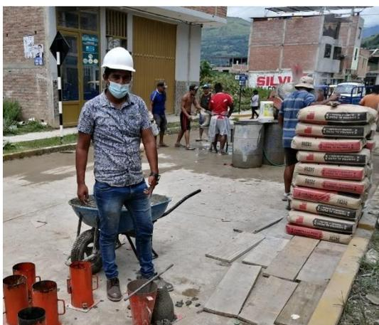
**Figura 65.** *Proceso de varillado del concreto dentro del cono de Abrams*
