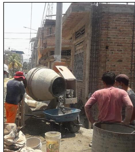
En la Figura 34 se presenta el concreto muestreado en la carretilla y los moldes listos para la realización de los ensayos respectivos en obra, mientras que en la Figura 35 se muestra el proceso de muestreo de concreto de la mezcladora y en las condiciones que se elaboró en obra. El muestreo se ha realizado siguiendo los procedimientos y utilizando los equipos e instrumentos de la NTP 339.036, 2017 “CONCRETO. Práctica para el muestreo de mezclas de concreto fresco”.
