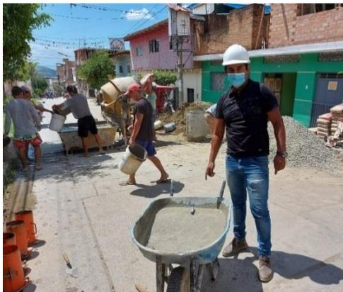
**Figura 59.** *Temperatura del concreto = 28.5 °C*
