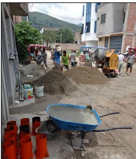
**Figura 35.** *Muestreo de concreto en obra 02*
