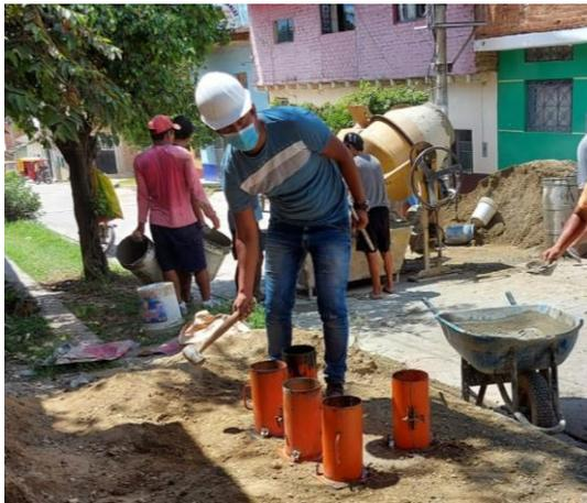
**Figura 69.** Elaboración de testigos de concreto
