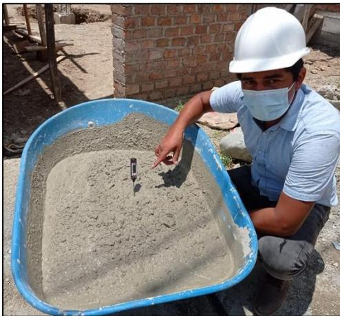
**Figura 37.** *Temperatura del concreto*
