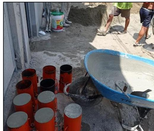
En la Figura 40 se presenta el proceso de varillado del concreto colocado en los moldes y en la Figura 41 se presenta los 10 testigos de concreto en obra, la misma cantidad que fueron elaborados en cada una de las obras y de las diferentes estructuras encontradas (cimentaciones, columnas y losas aligeradas). Los equipos e instrumentos que se utilizaron fueron los indicados
