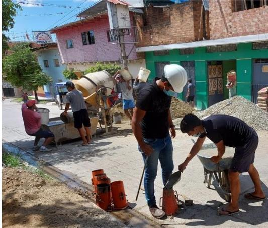
**Figura 61.** *Asentamiento del concreto = 11 pulgadas*
