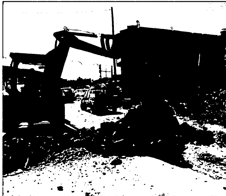
Figura 28 material sacado de la excavación de calicata N° 6 en la progresiva 0+769 como se puede observar el color negro y la humedad que posee el suelo es en este tramo donde se presenta la dificultad para mejorar la sub rasante ya que el estudio de suelos dio un CBR de 3%
