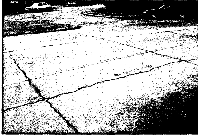
Figura 10. Fisura de reflexión de junta, se observa una fisura transversal que atraviesa todo el ancho del carril.
