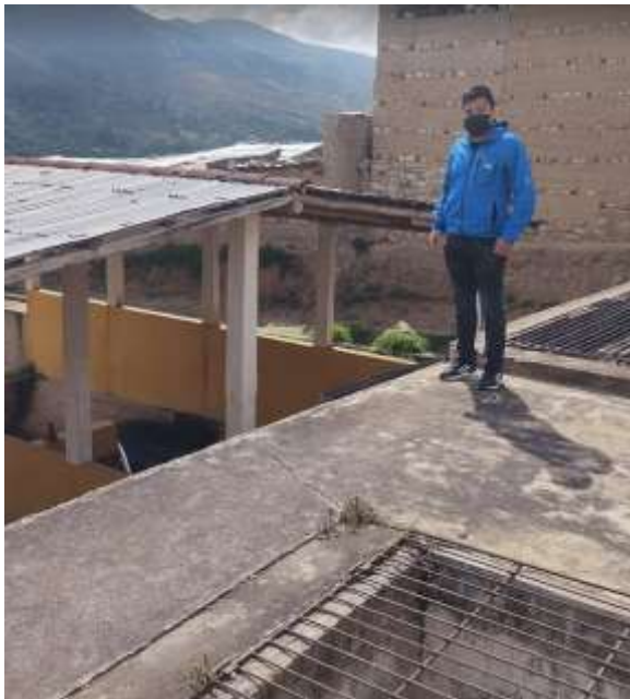
Fig. 34. Visita a la PTAR actual.
