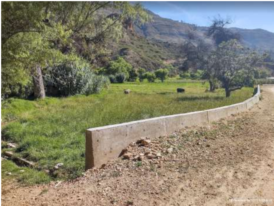
Fig. 50. Terreno para la construcción de la PTAR.
