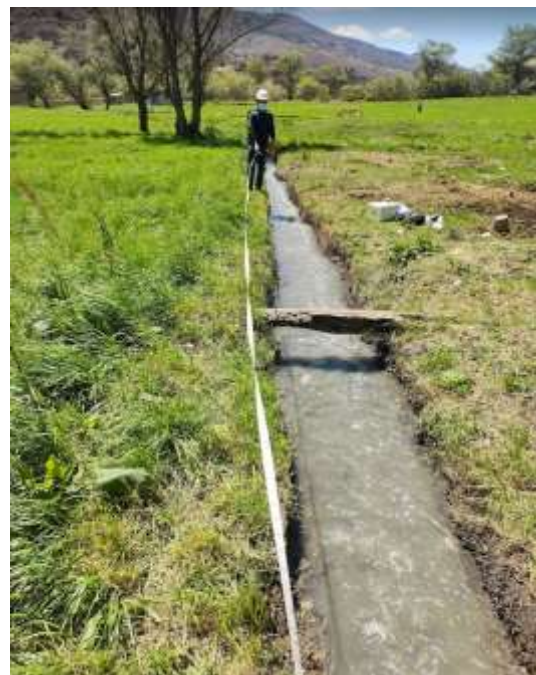
Fig. 39. Medición del tramo de aforo.
