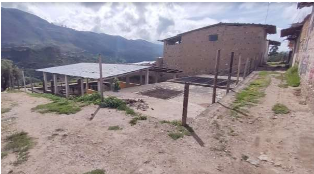
Fig. 28. PTAR actual (fuera de funcionamiento).
