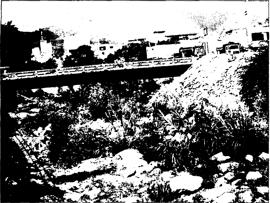
Figura 20. Vista lateral del puente Pakamuros, donde se tomó como referencia para la elaboración del estudio de investigación, el inicio de longitud de cauce se ubicó a 120 m. aguas abajo.
