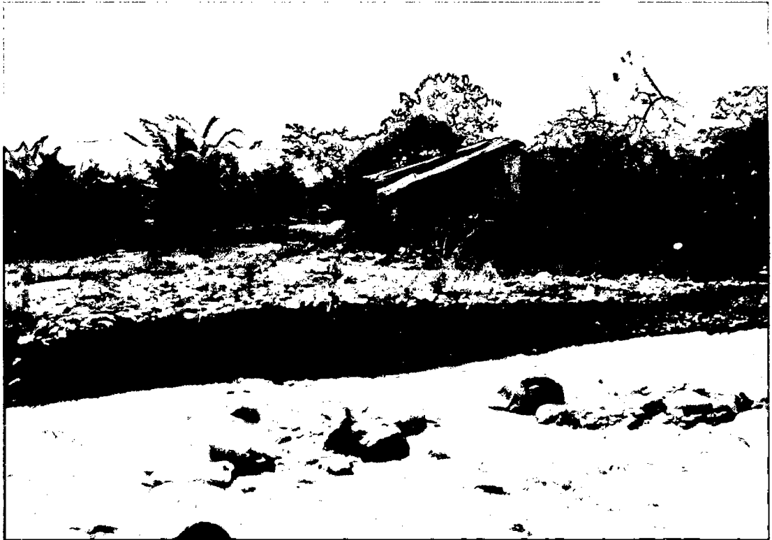
Figura 39. En la foto se observa a la margen derecha de la quebrada una vivienda cercana en la cual se debe colocar un muro gavión.
