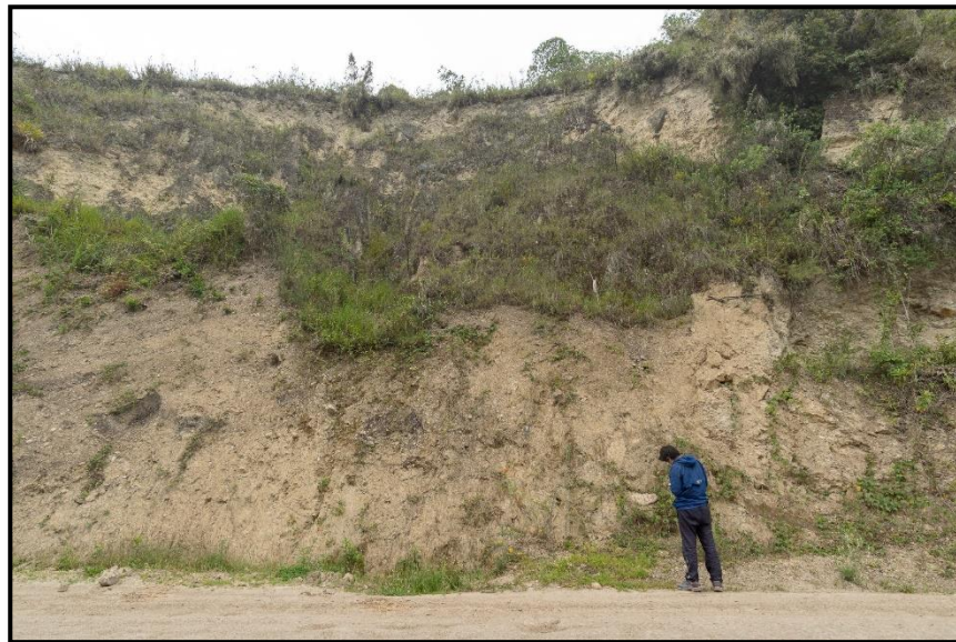
Fotografía 3. Registro de datos de caracterización visual en taludes. Progresiva 04+750 km
