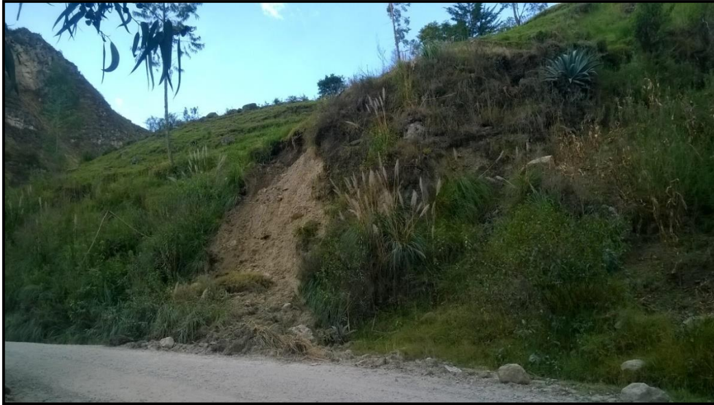
Fotografía 1. Identificación de zonas de deslizamiento. Progresiva 02+700 km
