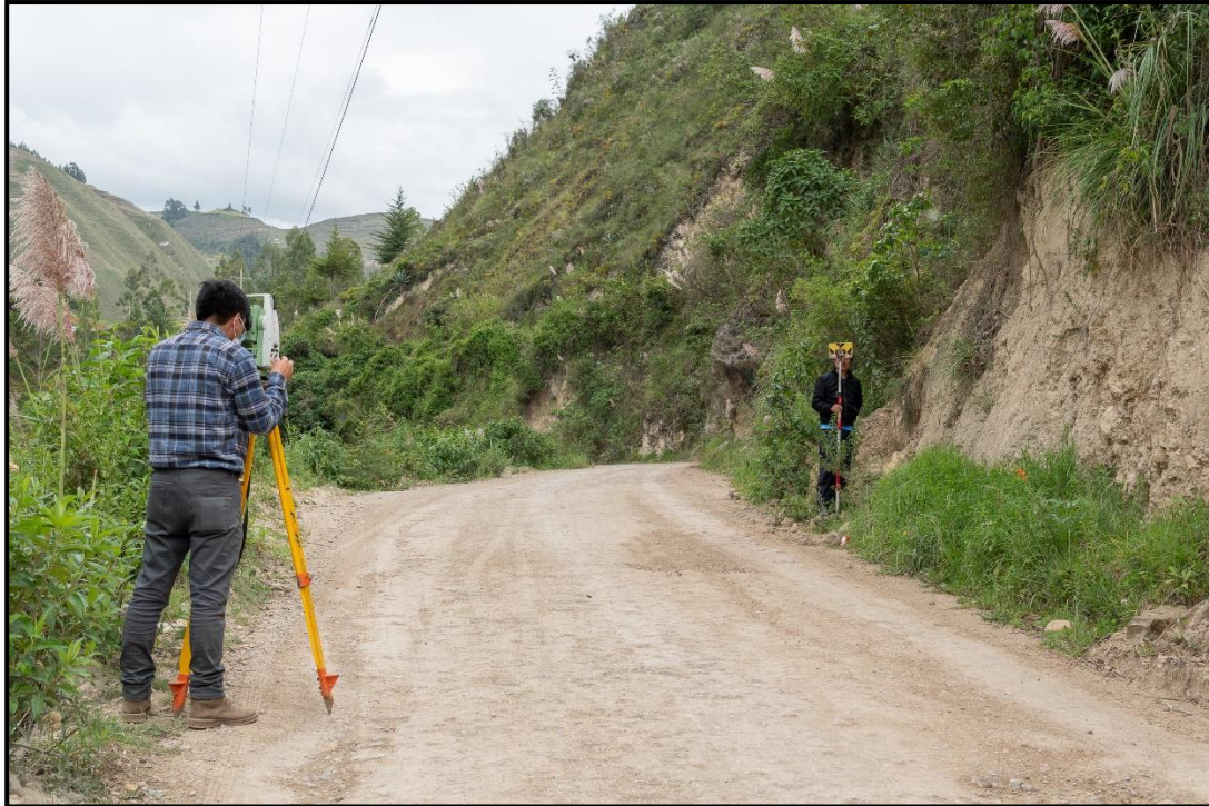
Fotografía 5. Levantamiento Topográfico, toma de puntos en el pie del talud. Progresiva 03+000 km
