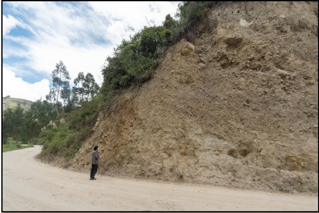
Fotografía 2. Descripción visual de características en los taludes
