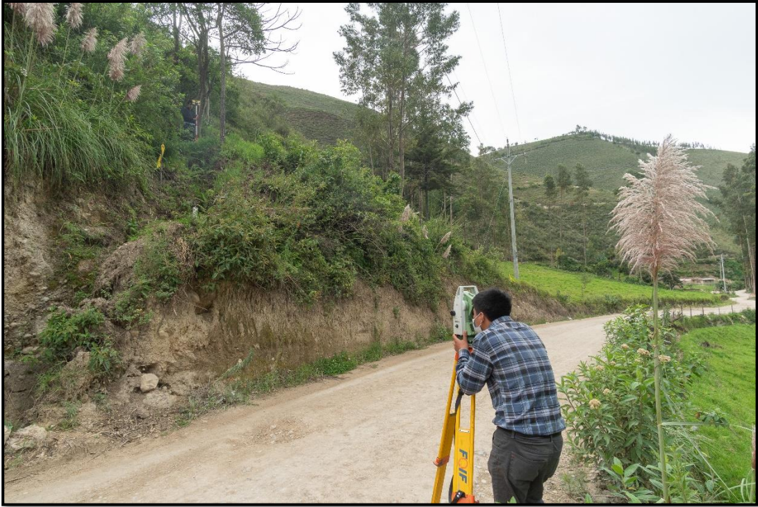
Fotografía 4. Levantamiento Topográfico, inicio del tramo en estudio. Progresiva 02+500 km
