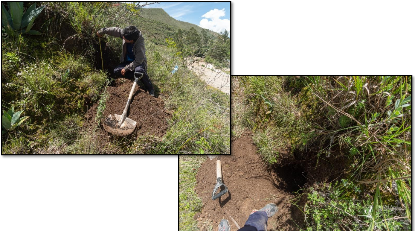
Fotografía 16. Calicata N°5: profundidad y material extraído. Progresiva 04+855 km
