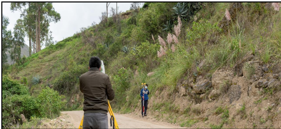
Fotografía 6. Levantamiento Topográfico, toma de puntos, parte intermedia del tramo en estudio. Progresiva 03+300 km
