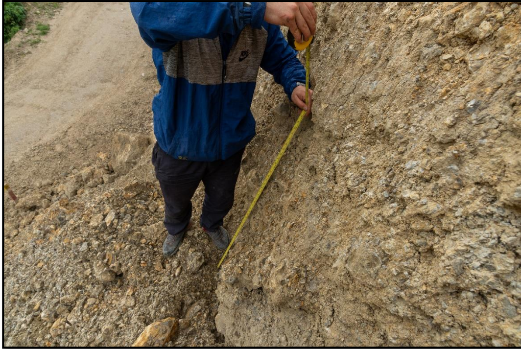
Fotografía 19. Calicata N°2, en talud expuesto: profundidad y material. Progresiva 03+248 km
