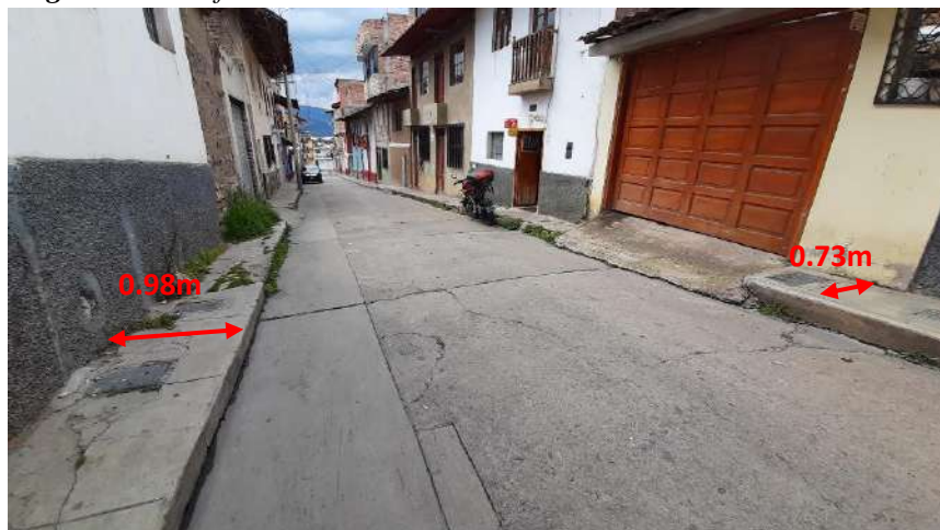
Figura 4.34. Infraestructura vial en el Jr. Soledad. cdra. 03
