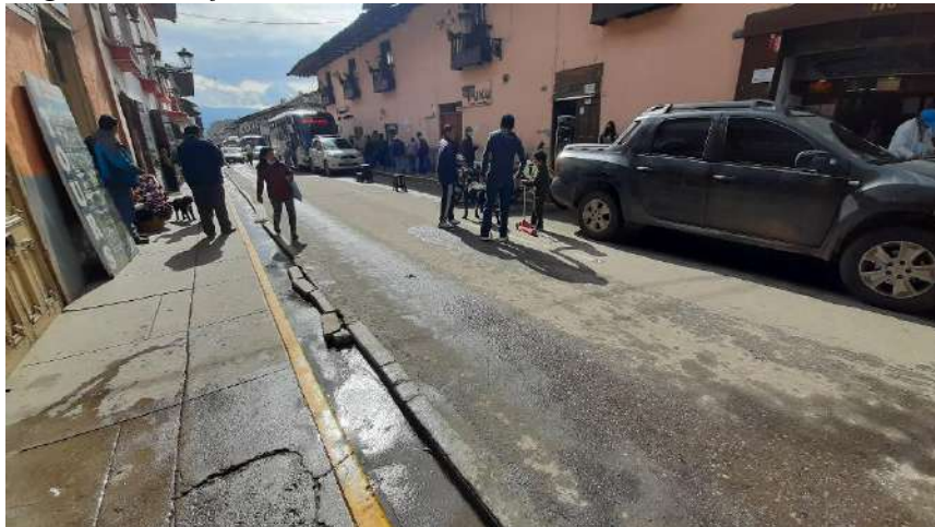
Figura 4.33. Infraestructura vial en el Jr. Batán. cdra. 01
