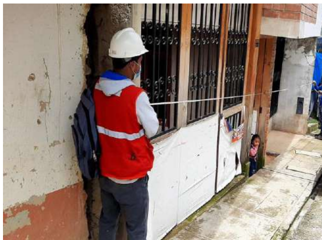
Medida de la fachada de la vivienda
