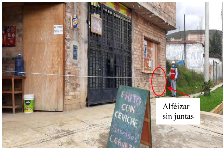
Tabiques sin columnetas y alféizar sin junta
