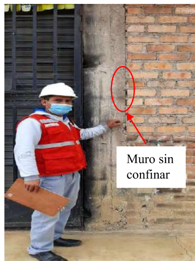
Tabiques sin columnetas y alféizar sin junta
