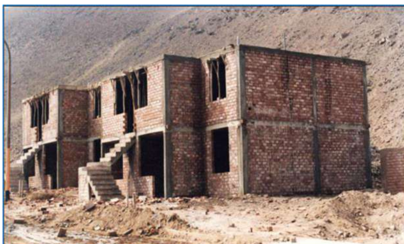
Figura N° 5. Edificio con estructura de albañilería confinada.
