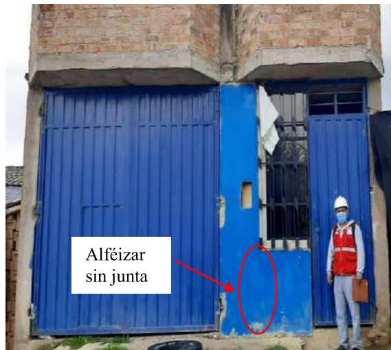
Exposicion del acero y alfeizar sin juntas
