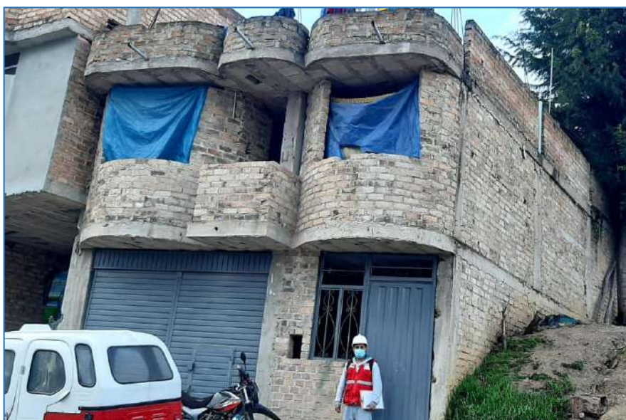
Figura N° 1. Vivienda autoconstruida en el Centro Poblado Puyllucana
