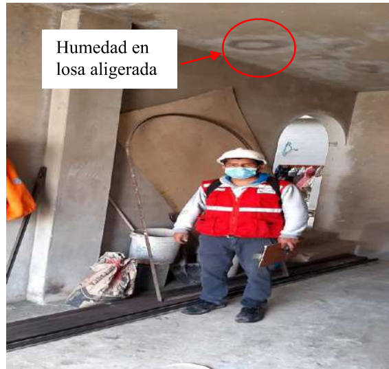
Humedad en losa aligerada
