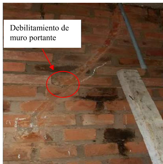
Cortes en diagonal en muros portantes
