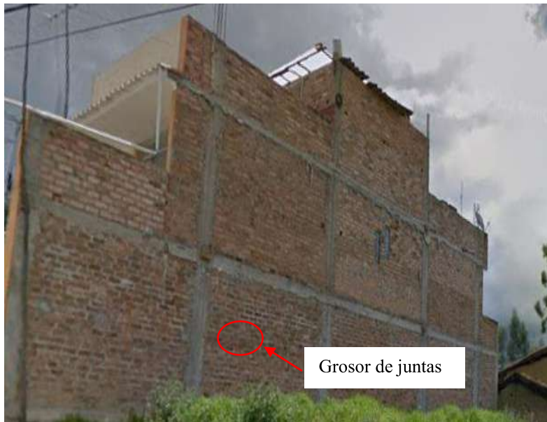
Grosor de junta mayor de 15 mm, tabiquería sin columnetas y alfeizar sin juntas
