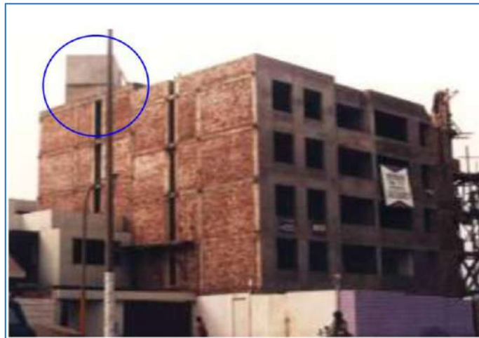
Figura N° 7. Concentración de masas (tanque elevado)
