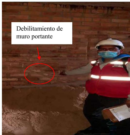
Grosor de junta mayor de 15 mm
