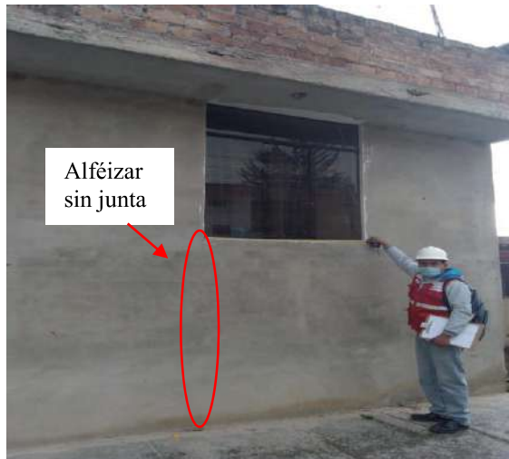
Tabiques sin columnetas y alfeizar sin junta
