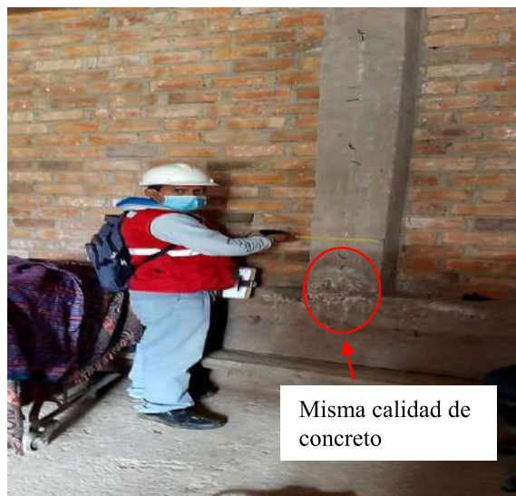
Concreto utilizado en el sobrecimiento y columna
