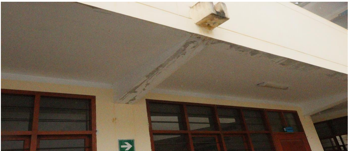
Fotografía 2. Desprendimiento de pintura en viga Y-8 primer nivel y voladizo
