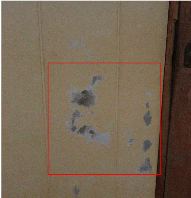
Fotografía 2. Desprendimiento de pintura en viga Y-8 primer nivel y voladizo
