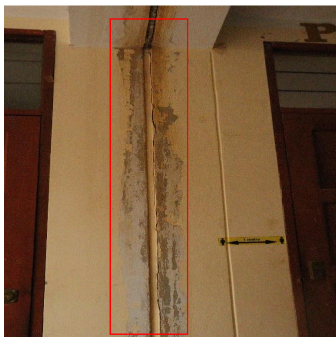
Fotografía 8. Fisuración al borde de la junta y desprendimiento de pintura
