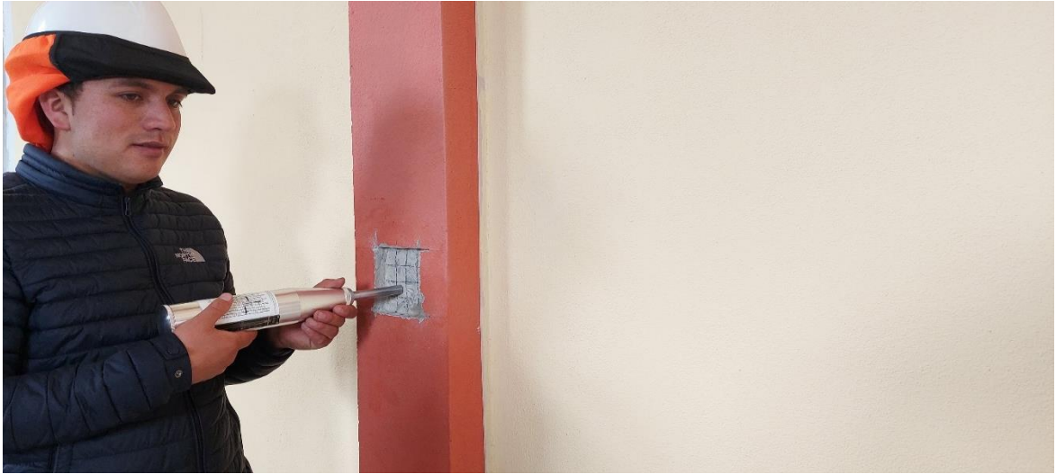
Fotografía 3: Ensayo con esclerómetro en columnas del 2do Nivel
