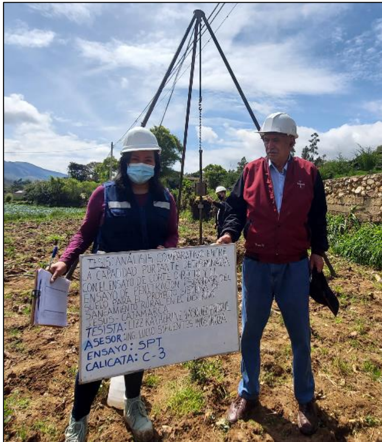
Fotografía 27. Ensayo de penetración estándar SPT3.
