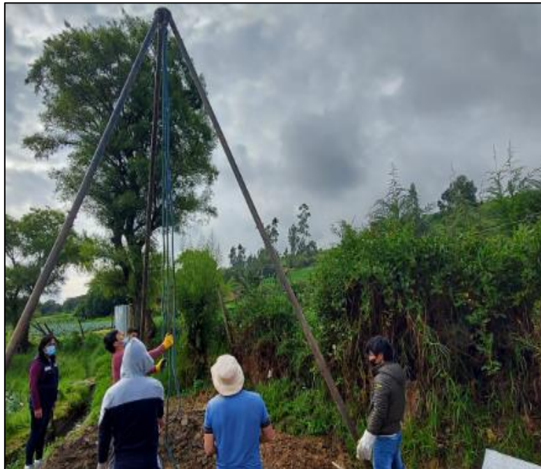
Fotografía 02. Instalación de equipos para el ensayo SPT.
