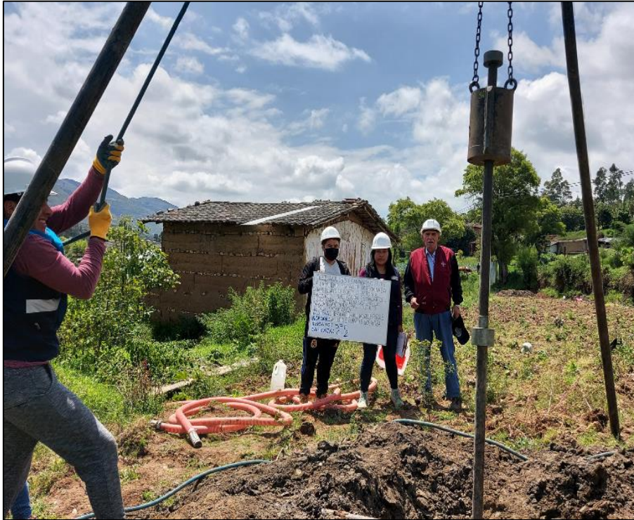
Fotografía 25. Ensayo de penetración estándar SPT2.
