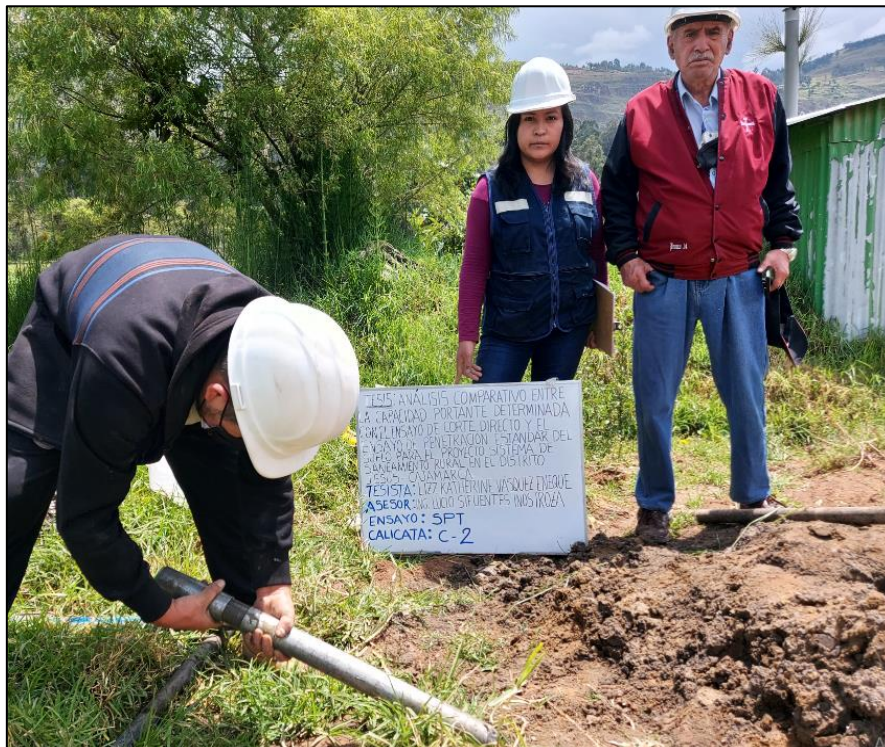
Fotografía 26. Extracción de las muestras del ensayo SPT2.
