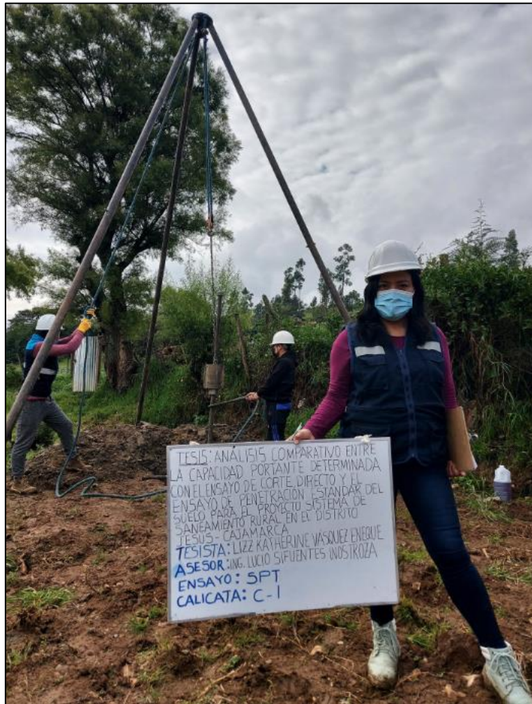
Fotografía 23. Ensayo de penetración estándar SPT1.
