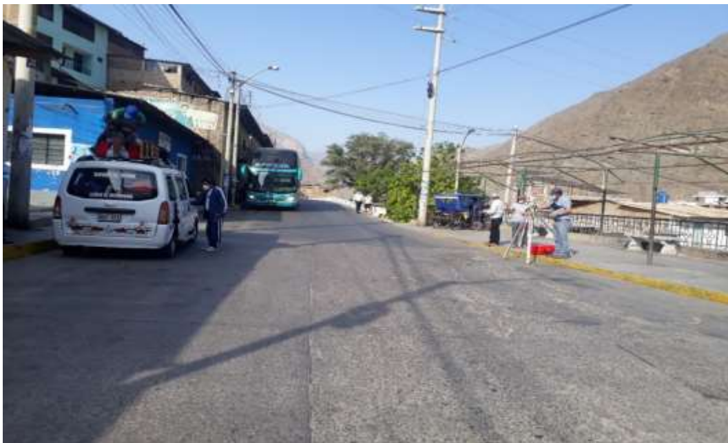
Foto N° 02: observamos al personal tècnico realizando la configuración de la Estacion Total ,punto de inicio Jr.Ignacio Prado.
