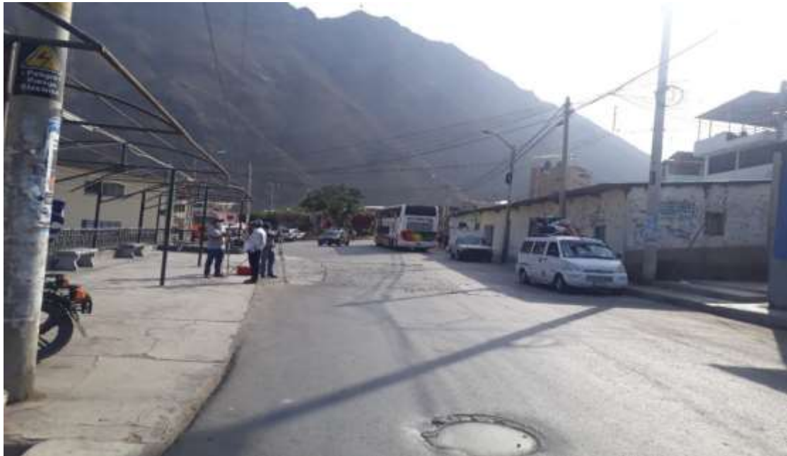
Foto N° 01: Se observa la planificación previa al inicio del trabajo de levantamiento topográfico.
