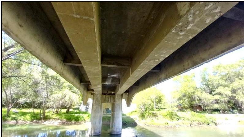
**Fotografía N°2.** Vista inferior de las vigas principales y vigas diafragmas, pilar central de la estructura.
