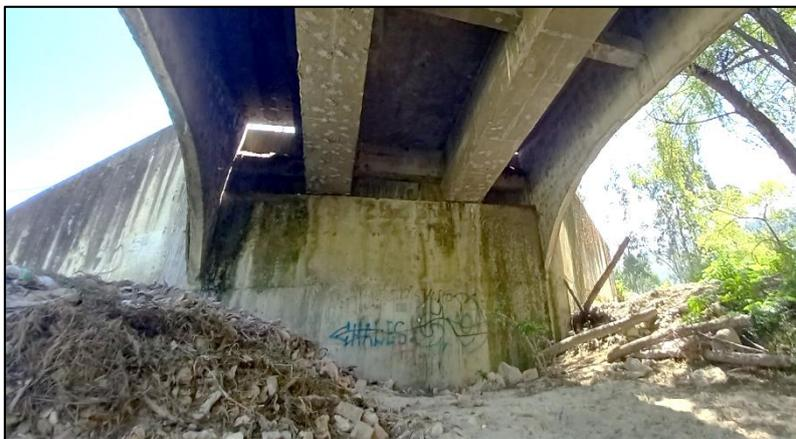
**Fotografía N°3.** Vista de las aletas y estribos que forman parte del puente.
