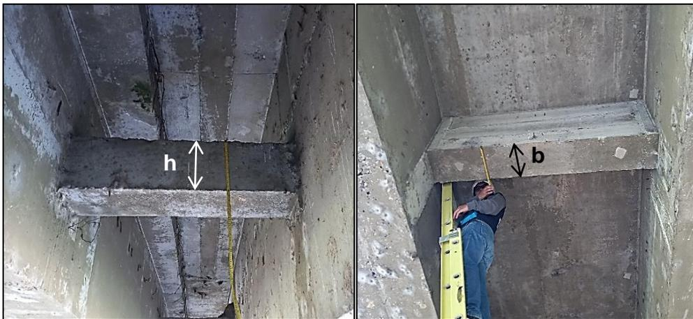
**Fotografía N°2.** Toma de medida del peralte y ancho de la viga diafragma.
