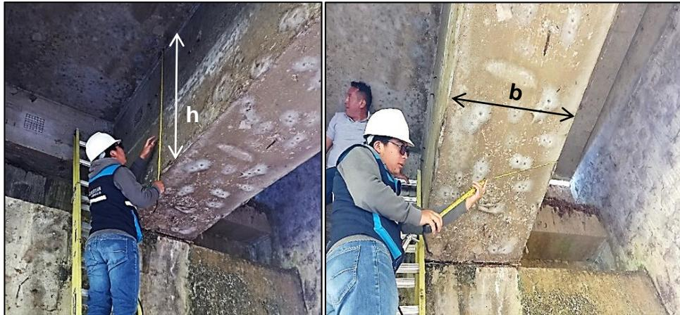
**Fotografía N°1.** Toma de medidas del peralte y ancho de la viga principal.
