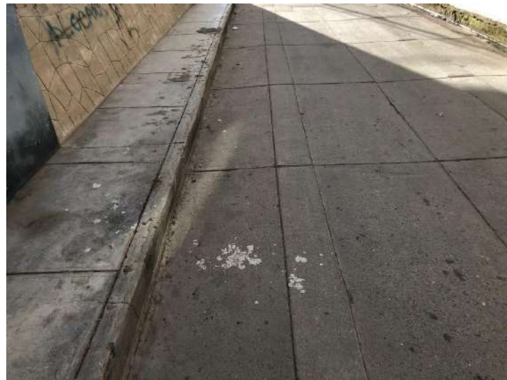
Fotografía N°28:Tramo 05 UM – 12 Presentación de Popouts
