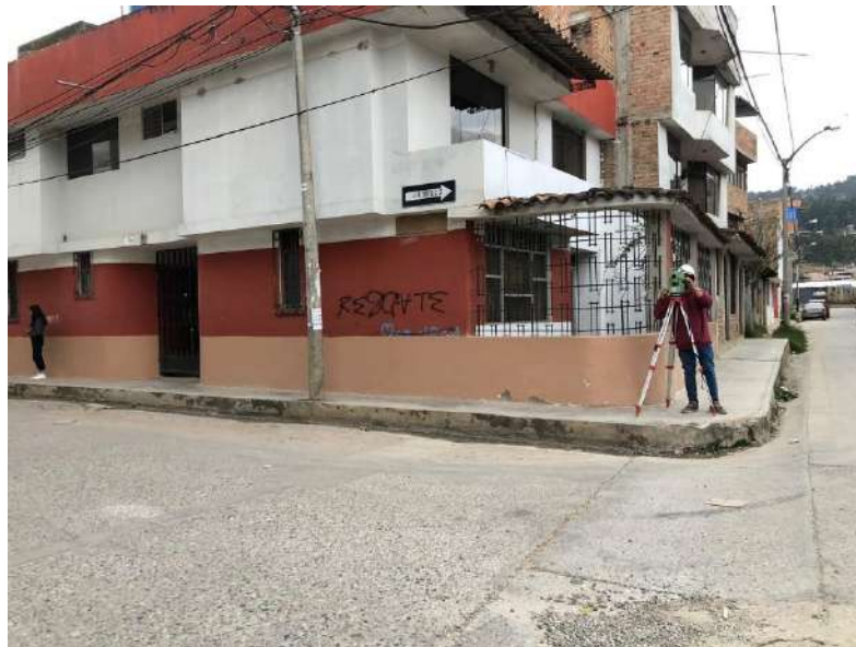
Fotografía N°61: Levantamiento topográfico calle Alejandro Ortiz Cuadra 02
