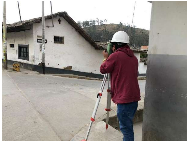
Fotografía N°60: Levantamiento topográfico calle Alejandro Ortiz Cuadra 01
