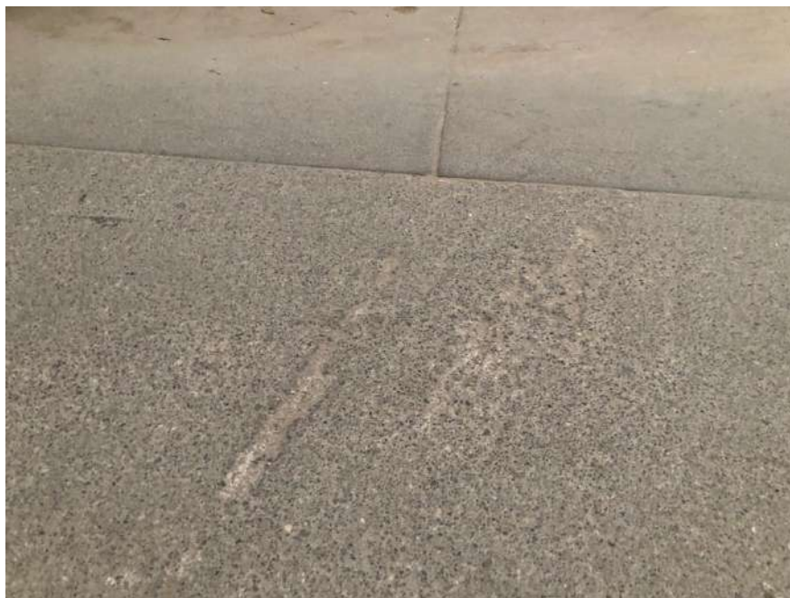
Fotografía N°53:Tramo 16 UM – 48 Pulimento de agregados
