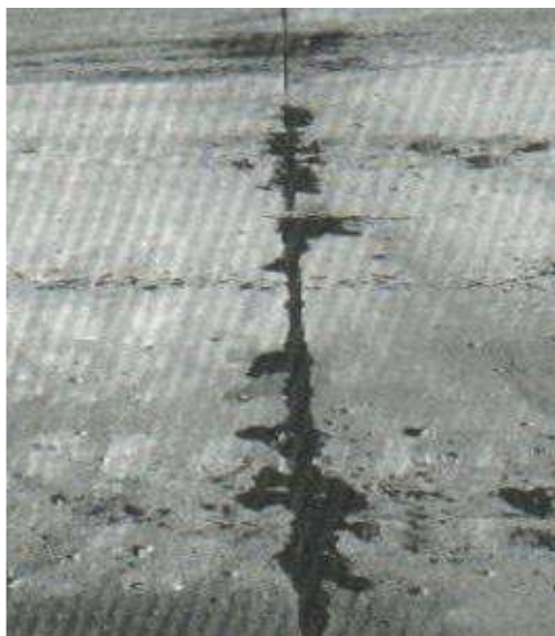
Fotografía N°13: : Vista típica de pulimiento de bombeo.
