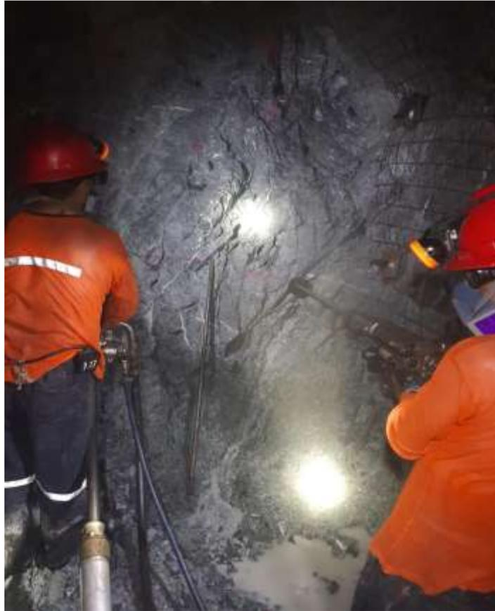
Fotografía 9: Perforación con máquina jackleg en galería del nivel 3175 Marsa
