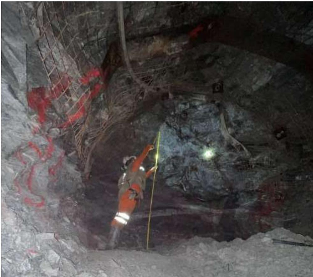
Fotografía 2: Sostenimiento de labor horizontal con perno más malla electrosoldada en la Cámara I nivel 3175 Marsa.
