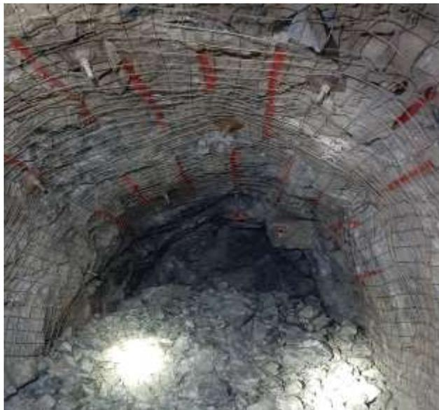
Fotografía 7: Sostenimiento de Crucero con perno Split set más malla en la Cámara I; nivel 3175 Marsa
