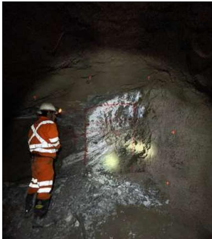
Fotografía 4: Sostenimiento con shotcrete en labores horizontales en la cámara I, nivel 3175 Marsa.
