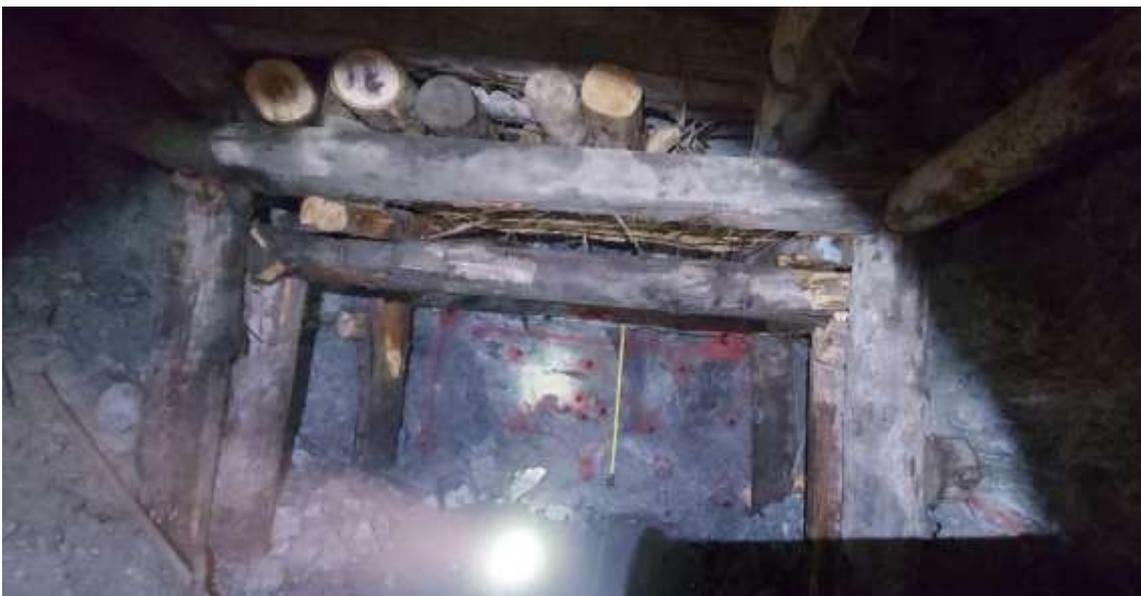
Fotografía 3: Sostenimiento con cuadros de madera en la Cámara I, nivel 3175 Marsa.
