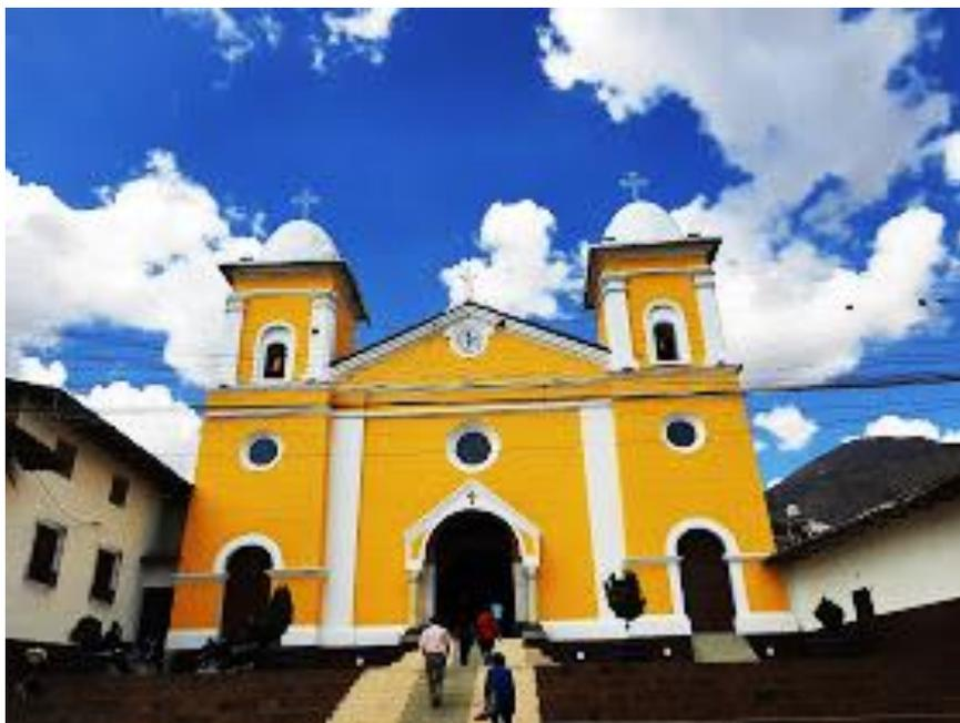
**Fotografía 04:** edificación N° 04, edificación de 01 piso, corresponde a la Iglesia San Nicolas de Tolentino, presenta irregularidades en elevación por la presencia de las dos torres. La dimensión de los muros es de 0.60 m de ancho.
