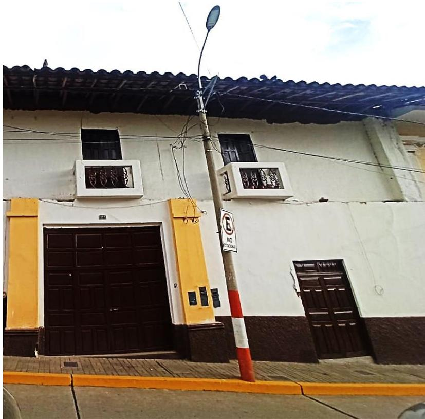
**Fotografía 12:** edificación N° 08, edificación de 02 pisos, no presenta irregularidades nie en planta ni altura, sin embargo, el muro del segundo piso es de menor dimensión al del primer piso. El muro del primer piso es de 0.90 m y el muro del segundo piso es de 0.70 m.
