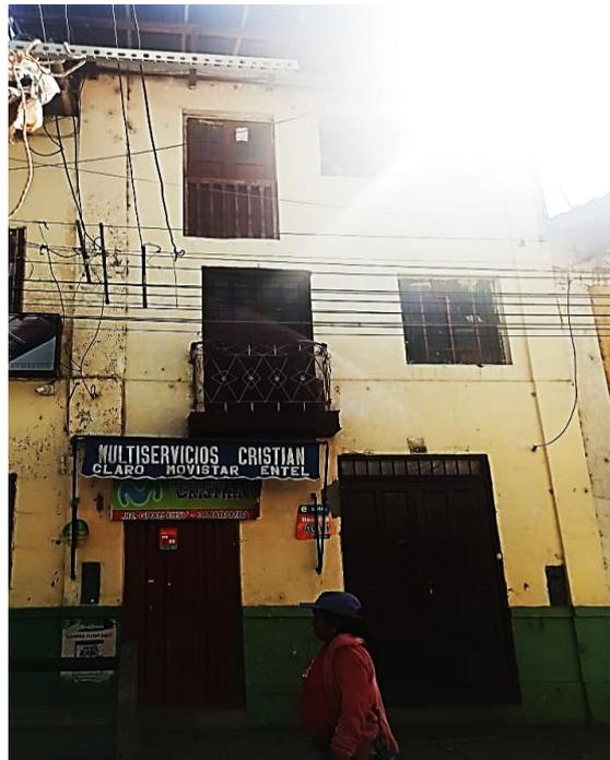
**Fotografía 15:** edificación N° 10, edificación de 03 pisos, presenta irregularidades en planta. Los muros tienen un espesor de 0.60 m. Se observa la presencia de balcones y parapetos.
