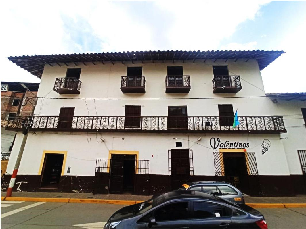
**Fotografía 01:** vivienda N° 01, edificación de 03 pisos, sin irregularidades en altura. Posee balcones y parapetos. Los muros de esta edificación miden alrededor de 0.90 m de ancho.
