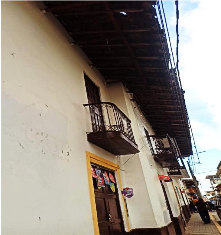
**Fotografía 03:** vivienda N° 02, edificación de 02 pisos, presenta irregularidades en planta y en elevación. Posee balcones y parapetos. Los muros de esta edificación miden alrededor de 0.60 m de ancho.
