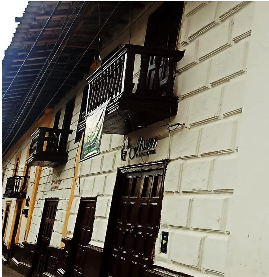
**Fotografía 07:** edificación N° 06, edificación de 02 pisos. El espesor de los muros es de 0.80 m de ancho. Se observa la existencia de cornisas, balcones y parapetos.
