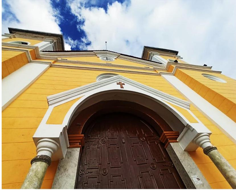
**Fotografía 05:** edificación N° 04, edificación de 01 piso, corresponde a la Iglesia San Nicolas de Tolentino, presenta irregularidades en elevación por la presencia de las dos torres. El espesor de los muros es 0.60 m de ancho. Se observa la existencia de cornisas.
