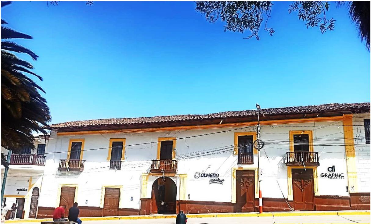
**Fotografía 06:** edificación N° 05, edificación de 02 pisos, presenta irregularidades en planta. El espesor de los muros es de 0.90 m de ancho. Se observa la existencia de cornisas, balcones y parapetos.
