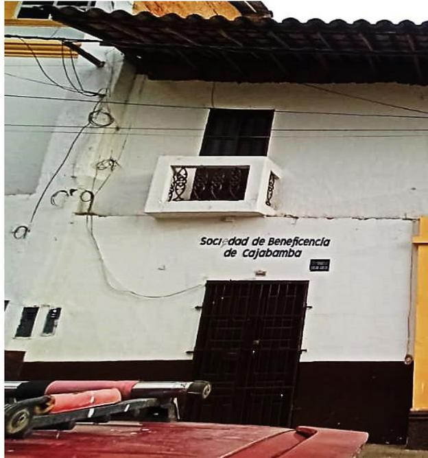
**Fotografía 14:** edificación N° 09, edificación de 02 pisos, no presenta irregularidades nie en planta ni altura, sin embargo, el muro del segundo piso es de menor dimensión al del primer piso. El muro del primer piso es de 0.90 m y el muro del segundo piso es de 0.70 m. Se observa la presencia de balcones y parapetos.
