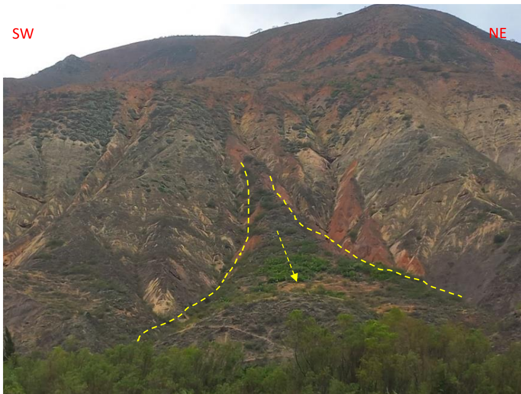
Figura 35. Cono de deyección ubicado en el flanco frente al caserío La Viña
