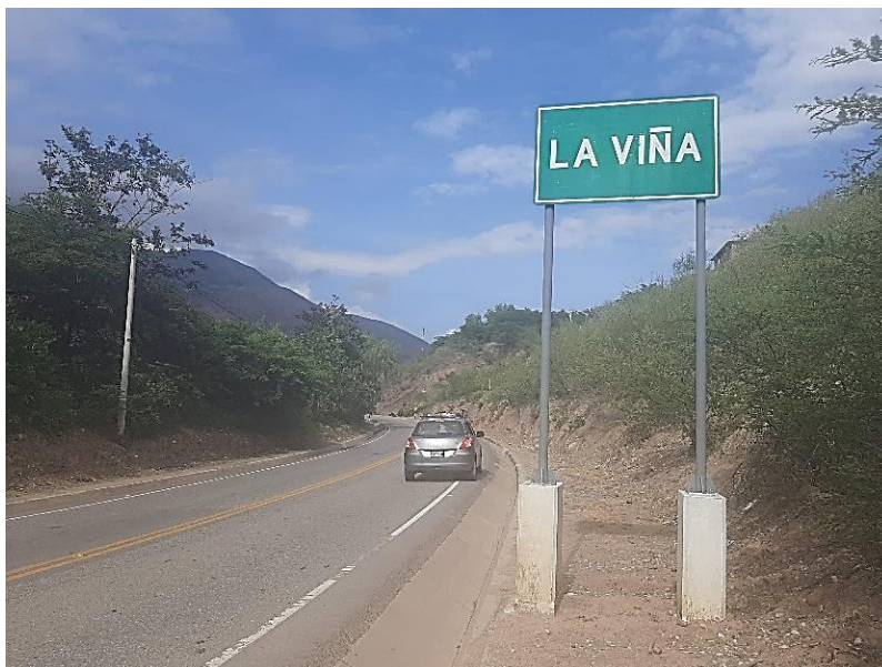
Figura 15 . Carretera de accesibilidad Magdalena-Cajamarca
