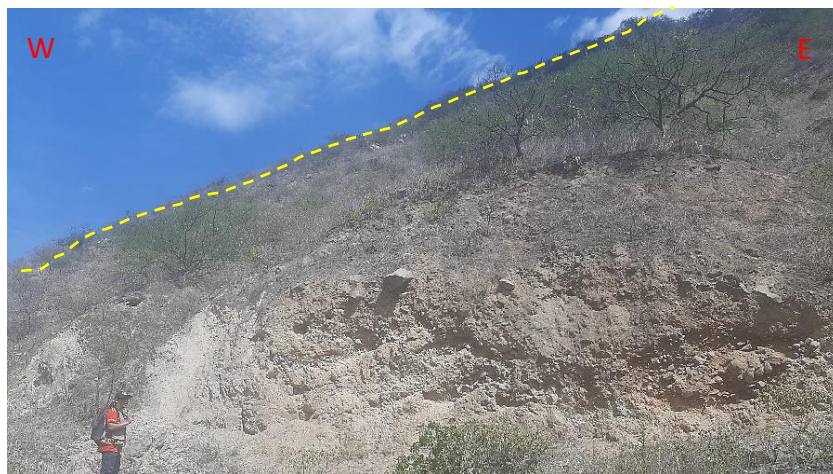
Figura 65. Ladera erosional denudacional en el C° El Puquio. Se visualiza un espesor considerable del depósito cuaternario en el flanco del cerro.
