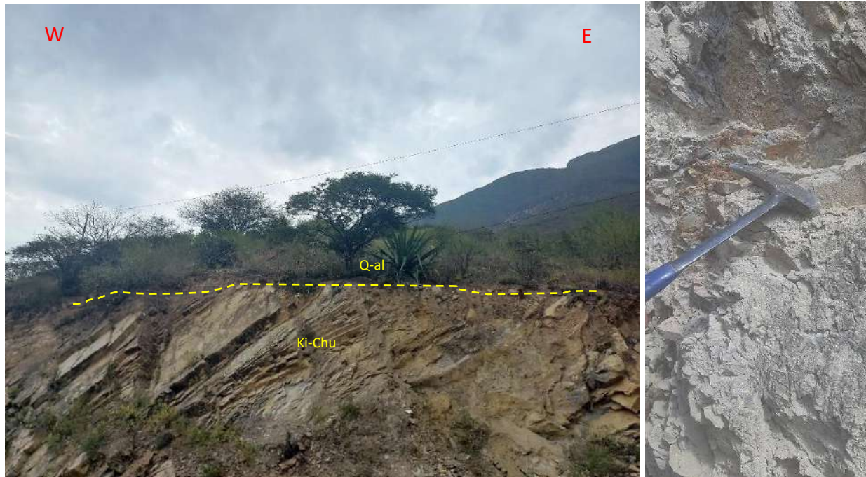
Figura 22. En el corte de carretera, flanco sur del Cerro El Puquio se observan estratos de caliza de la Fm. Chúlec. Con elevado ángulo de buzamiento por el anticlinal volcado.
