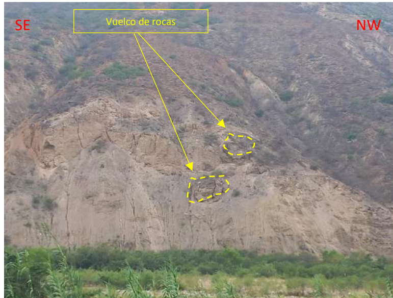
Figura 62. Vista de bloques desprendidos en el escarpe estructural kárstico de la Fm. Chulé
