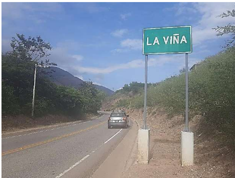
Figura 15 . Carretera de accesibilidad Magdalena-Cajamarca
