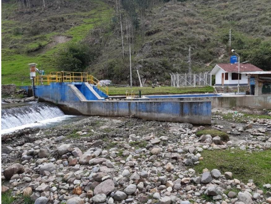
Figura 5. Captación río Grande (RGAM), para la planta de agua potable El Milagro, en época de estiaje.
