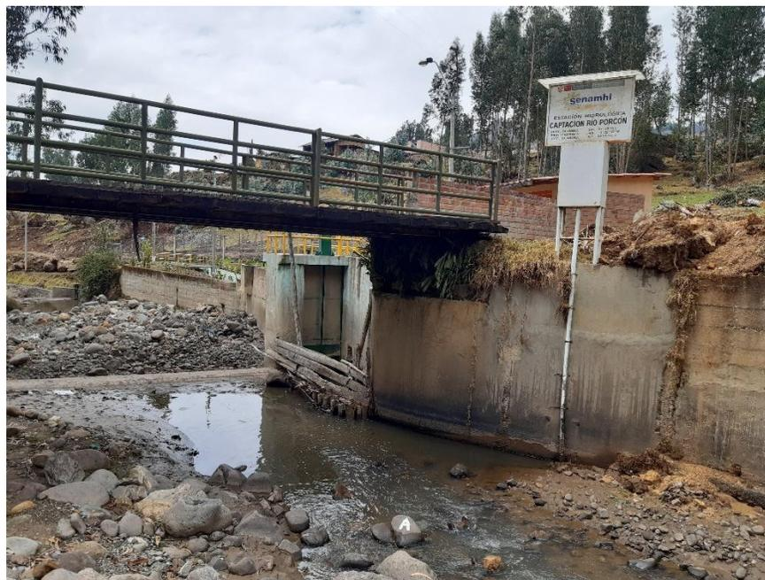
Figura 6. Captación río Porcón (RPAM), para la planta de agua potable El Milagro, en época de estiaje.
