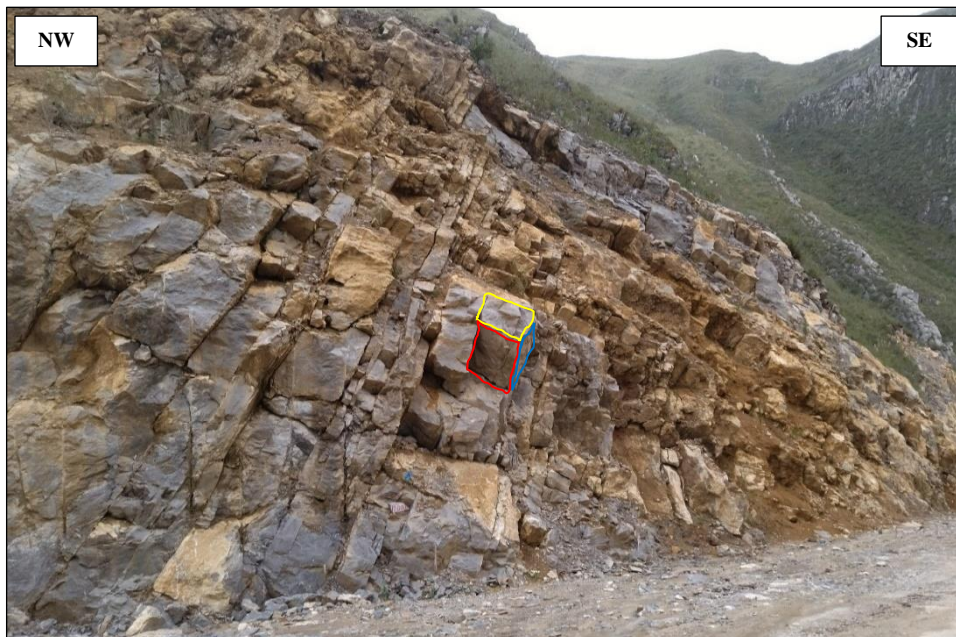
Foto 14: Presencia de familia de discontinuidades en calizas de la Formación Cajamarca en la progresiva km 07 + 020. Coordenadas: E 787204, N 9216137.
