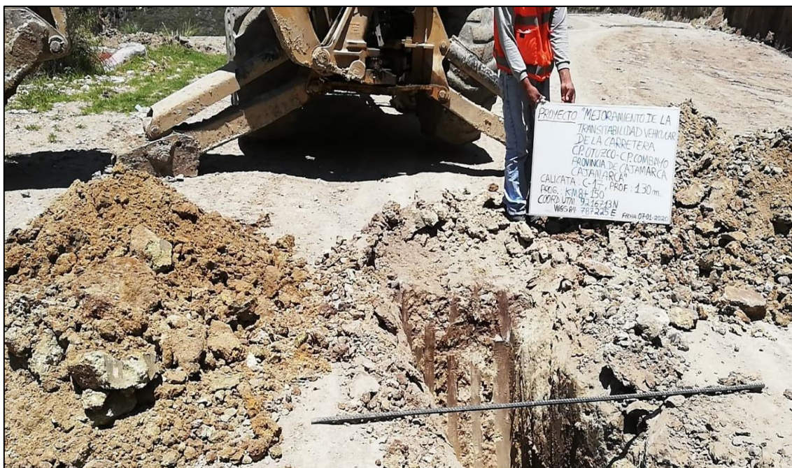
Foto 20: Exploración geotécnica del terreno de fundación de la plataforma de la carretera en el punto crítico N° 02.
