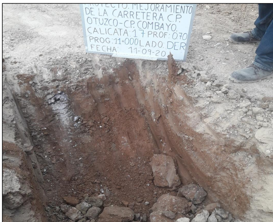
Foto 22: Exploración geotécnica del terreno de fundación de la plataforma de la carretera en el punto crítico N° 04.
