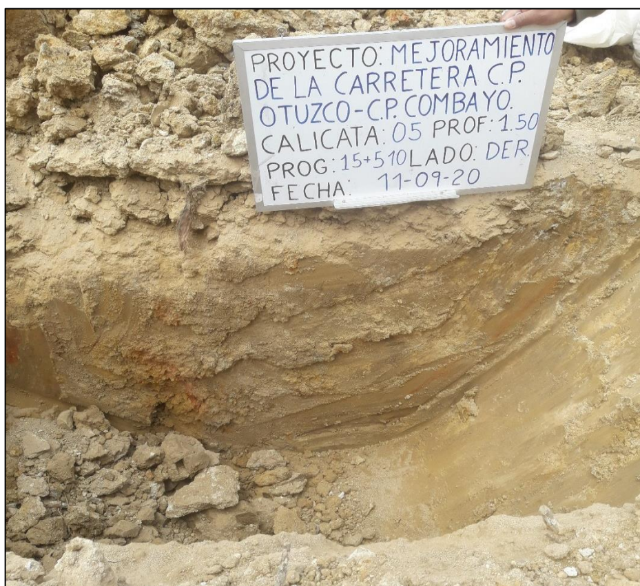
Foto 23: Exploración geotécnica del terreno de fundación de la plataforma de la carretera en el punto crítico N° 05.
