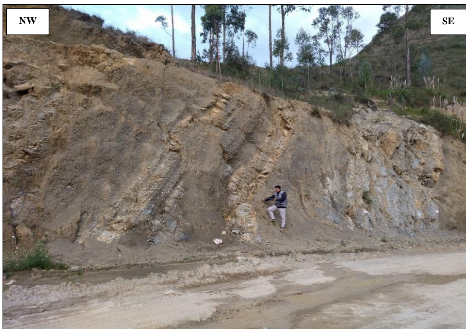
Foto 05: Limolitas y calizas, con estratificación delgada pertenecientes a la Formación Celendín en la progresiva km 07 + 345. Coordenadas: E 787253, N 9216428.
