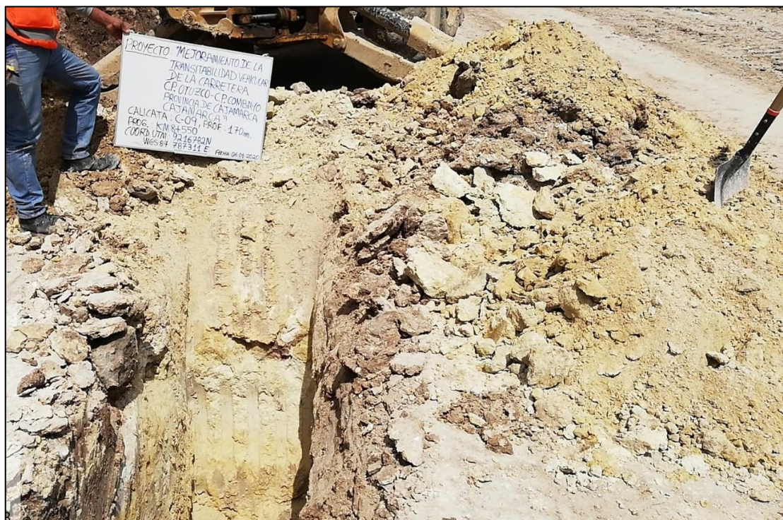
Foto 21: Exploración geotécnica del terreno de fundación de la plataforma de la carretera en el punto crítico N° 03.
