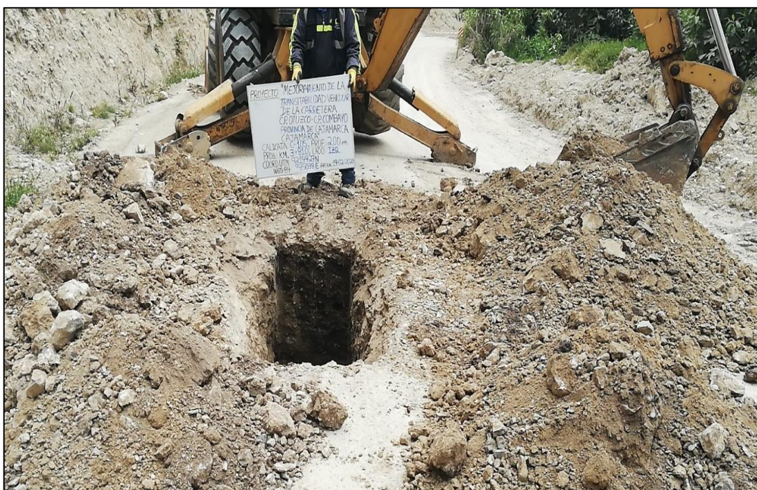
Foto 19: Exploración geotécnica del terreno de fundación de la plataforma de la carretera en el punto crítico N° 01.
