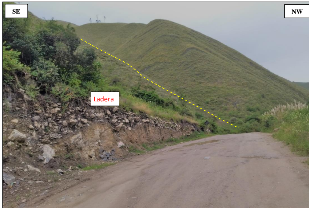
Foto 17: Ladera con pendiente aproximada del 40%. Se encuentra en la progresiva km 06 + 080. Coordenadas: E 786890, N 9215359.
