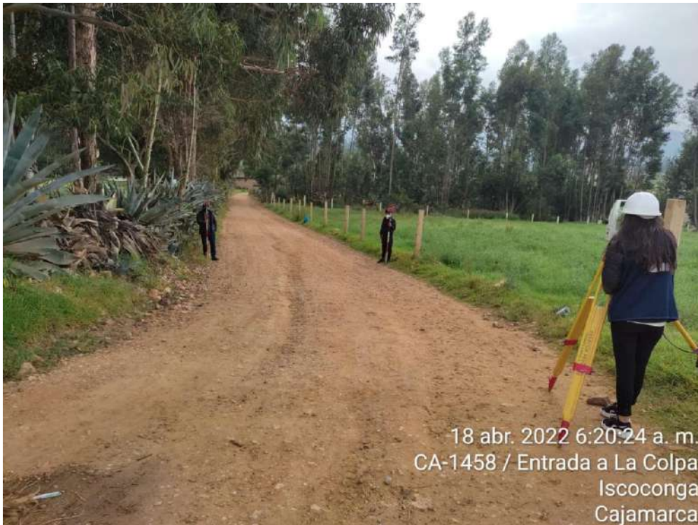
Fotografía 3 Levantamiento topográfico: Toma de puntos topográficos
