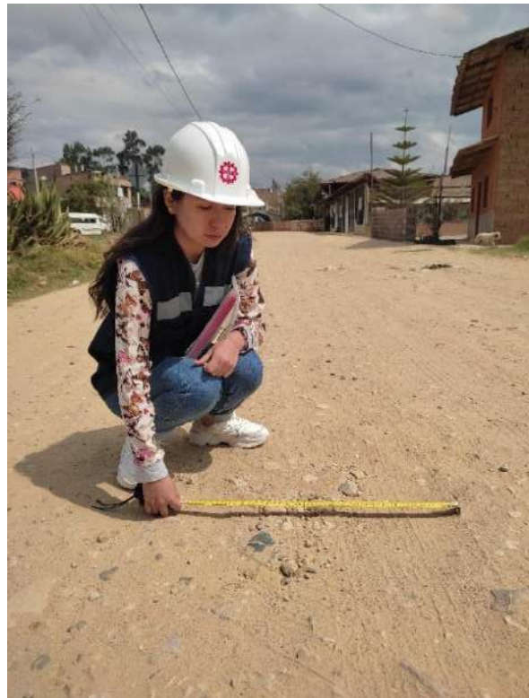
Fotografía 8 Toma de datos de fallas presentes en una unidad muestral para el método TMH-
