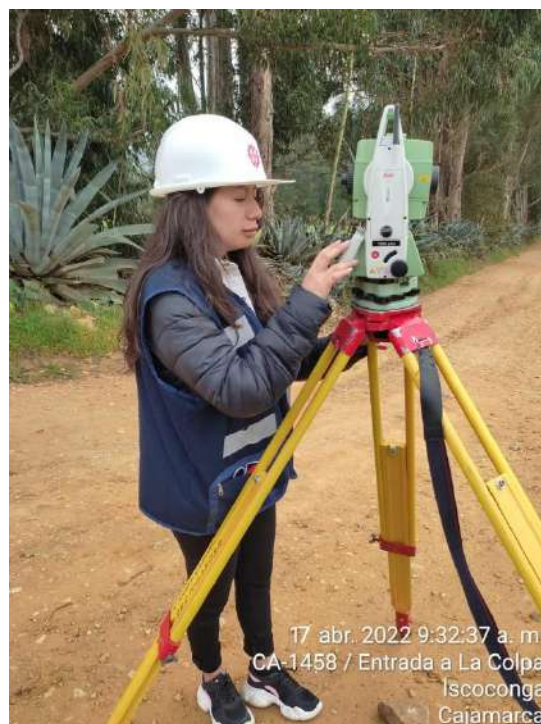
Fotografía 2 Día 1 del levantamiento topográfico: Montaje de la estación total
