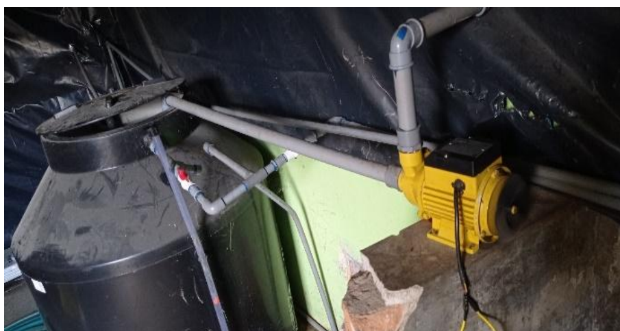
Imagen 13; Instalación del sistema de riego presurizado para semillas de cebada ( Hordeum vulgare ), avena ( Avena sativa ) y trigo ( Triticum sativum )
