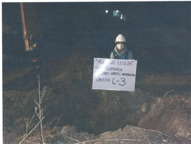
Fotografía N° 05: Vista general de la calicata C-3.
