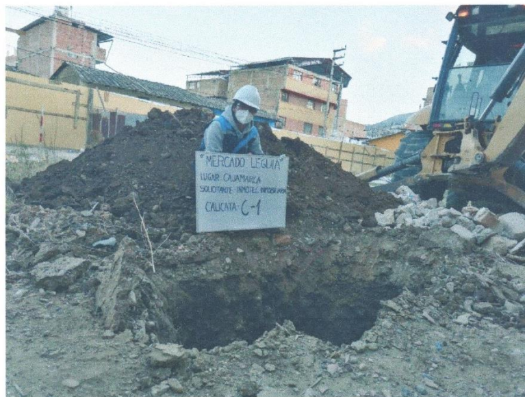
Fotografía N° 01: Vista general de la calicata C-1.
