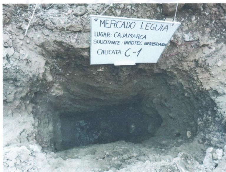
Fotografía N° 02: Vista del perfil estratigráfico de la calicata C-1.
