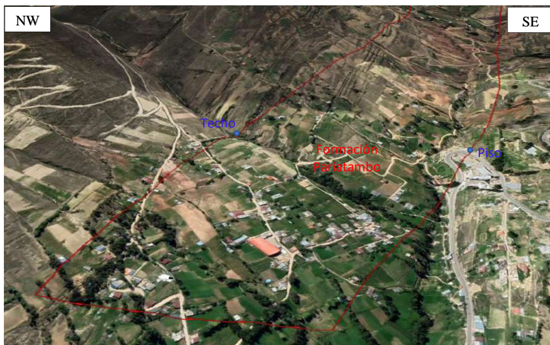
Figura 4.8. Vista panorámica desde Google Earth, delimitando la Formación Pariatambo: Piso y techo, cortado transversalmente por la Quebrada: Puyllucana y Samana, y carretera provincial - Zona Puyllucana.
