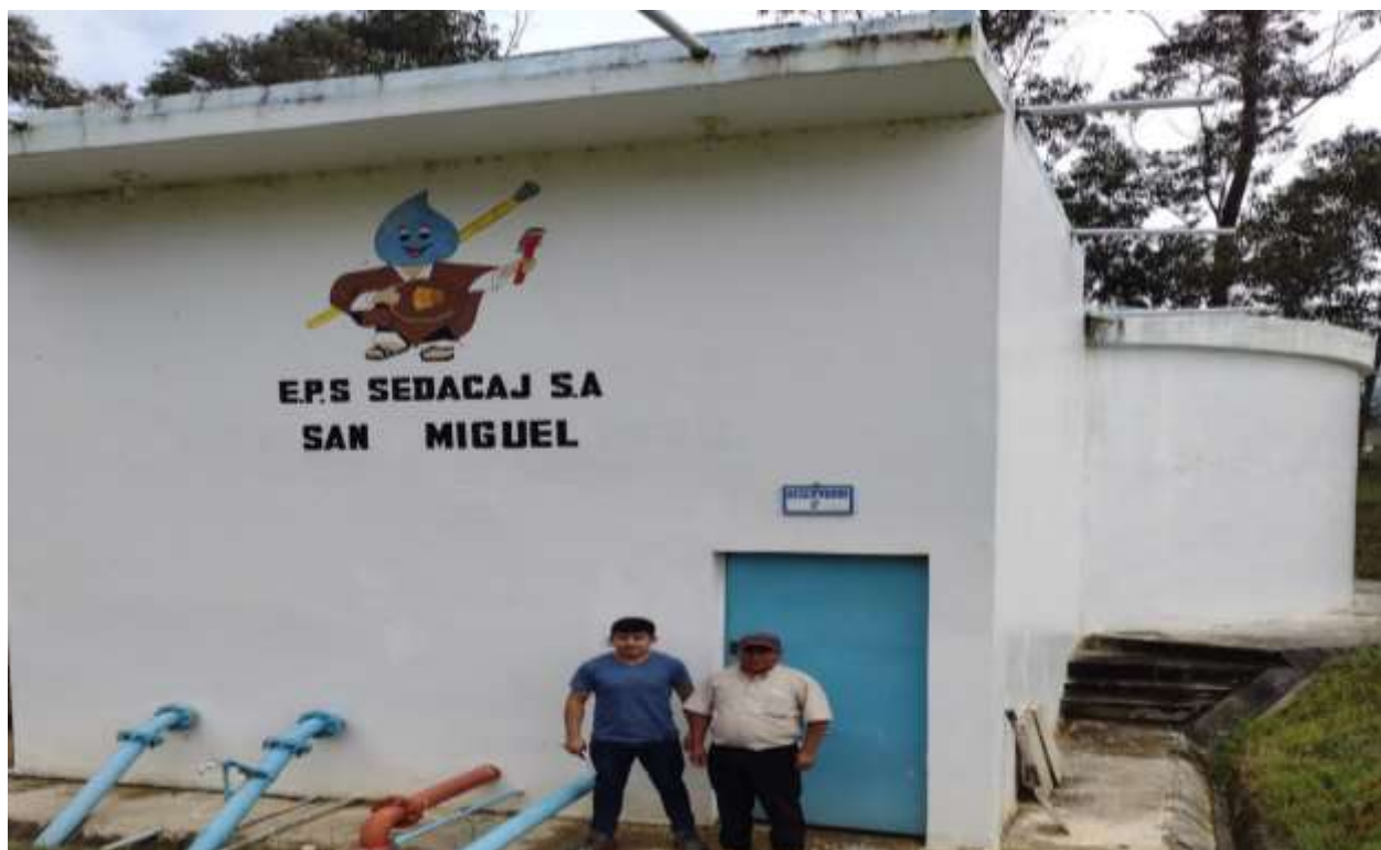
Fotografía N° 5: Reservorio de agua potable.
