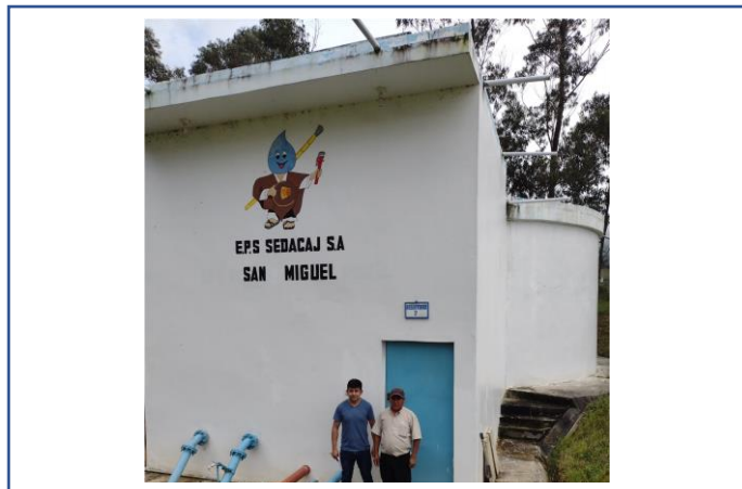
Fotografía 01: Vista Reservorio PTAP San Miguel
