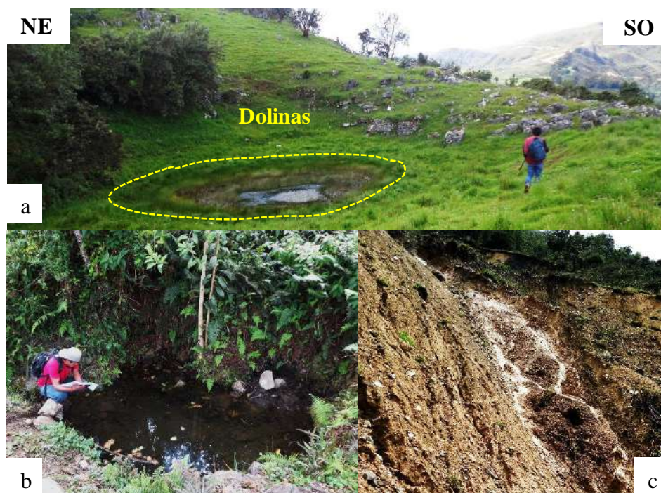
Foto 10. En “a” se observa dolinas donde se deposita agua de lluvia, en “b” filtración de agua en terrenos agrícolas y en “c” filtración de agua en deslizamientos activos.
